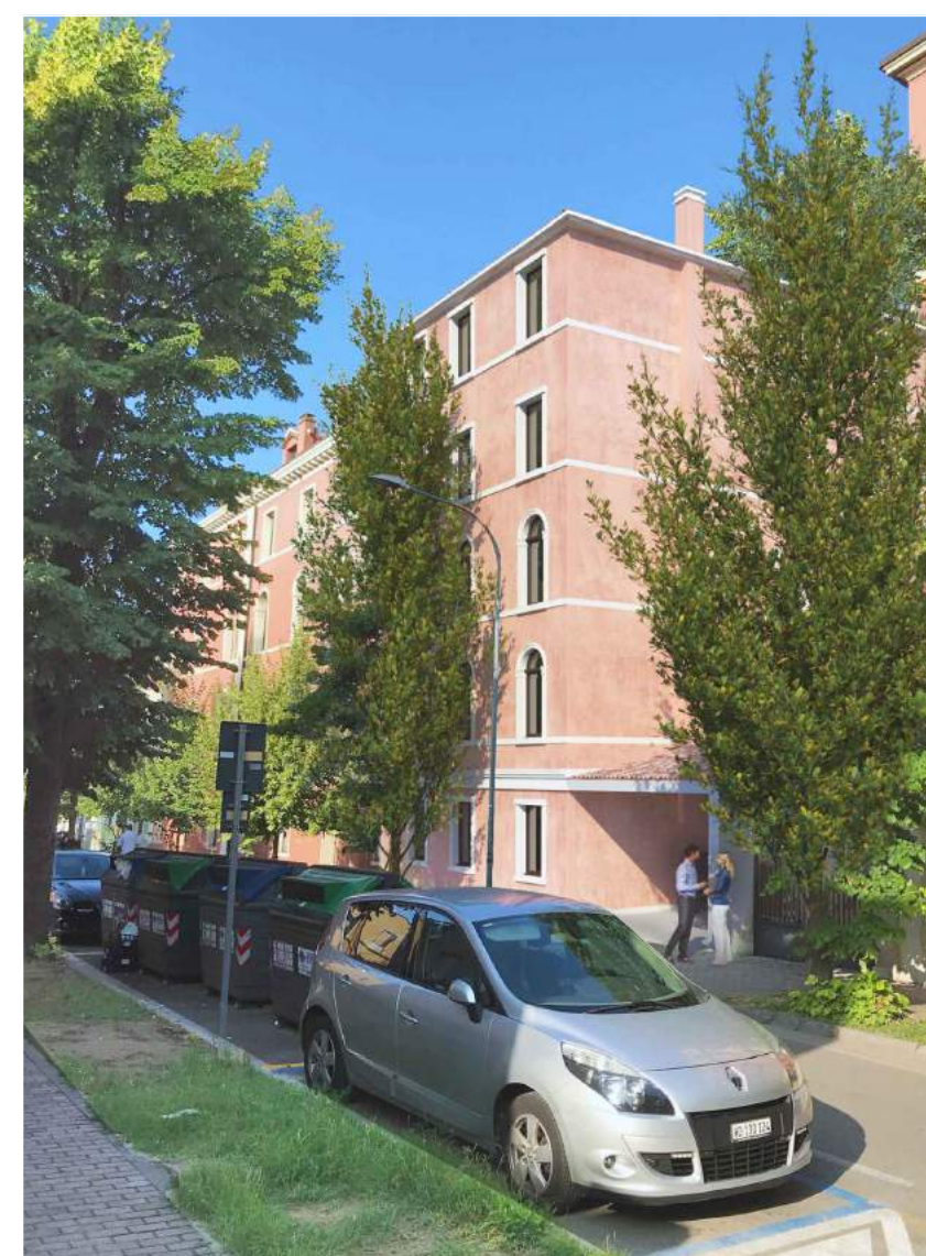
Vista da Via Perasto
