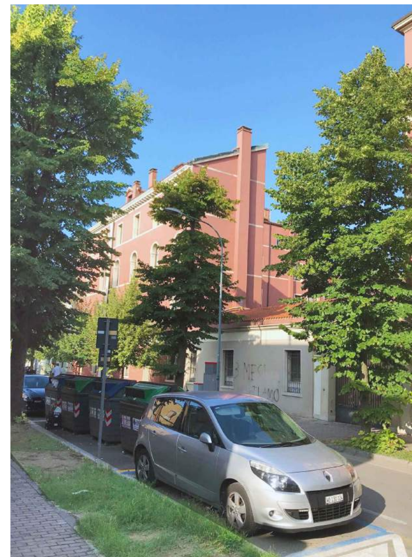
Vista da Via Perasto
