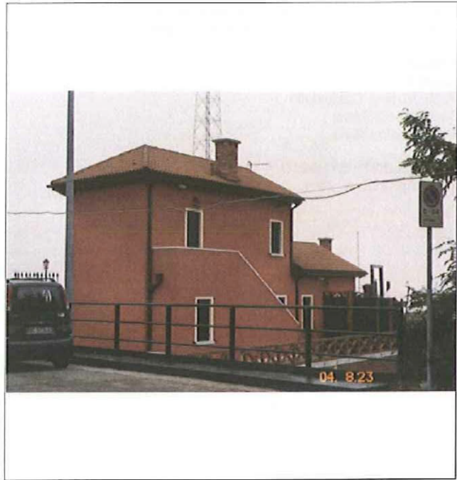
FRONTE NORD-OVEST VISTO DALLA STRADA
