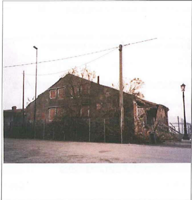
FRONTE NORD-OVEST VISTO DALLA STRADA
