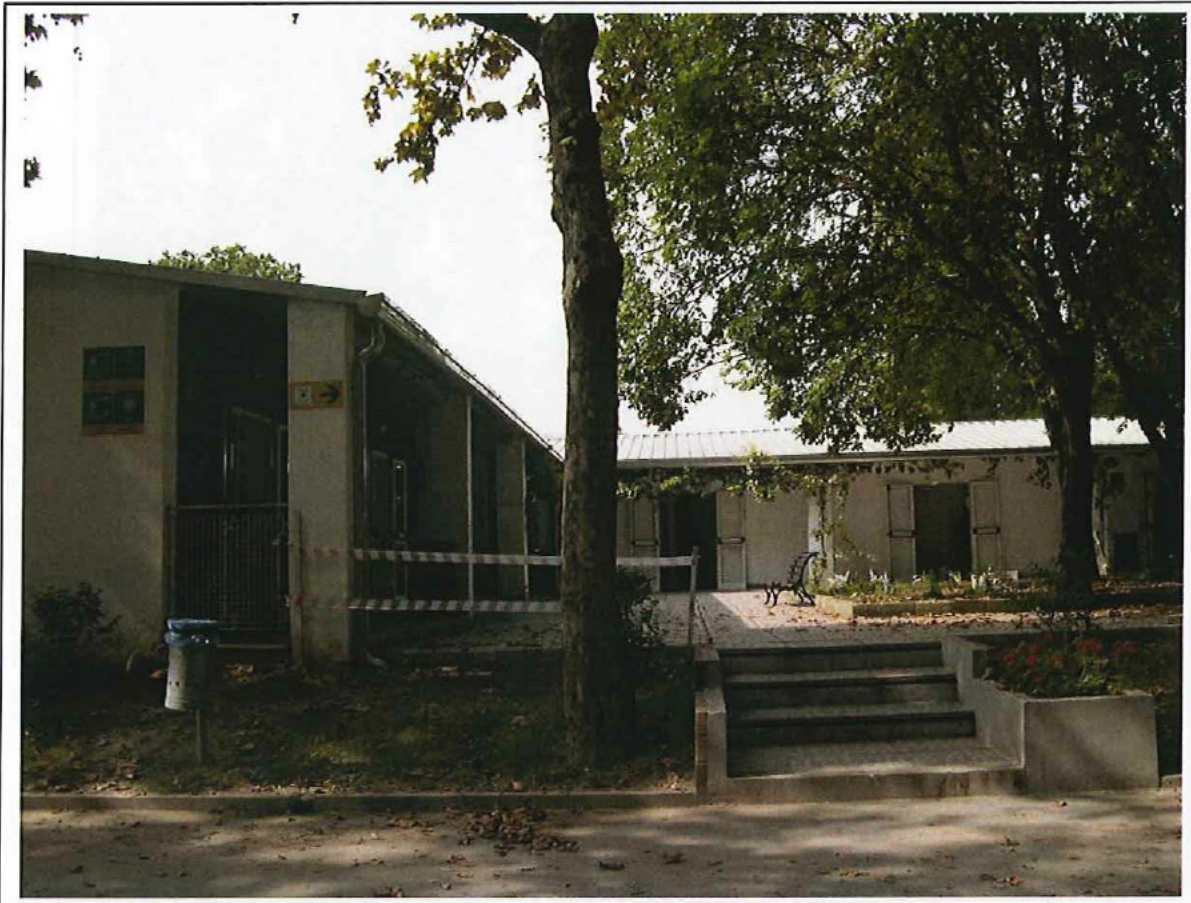
STRUTTURA LAVANDERIA CAMPEGGIO n. 7 cono 12
