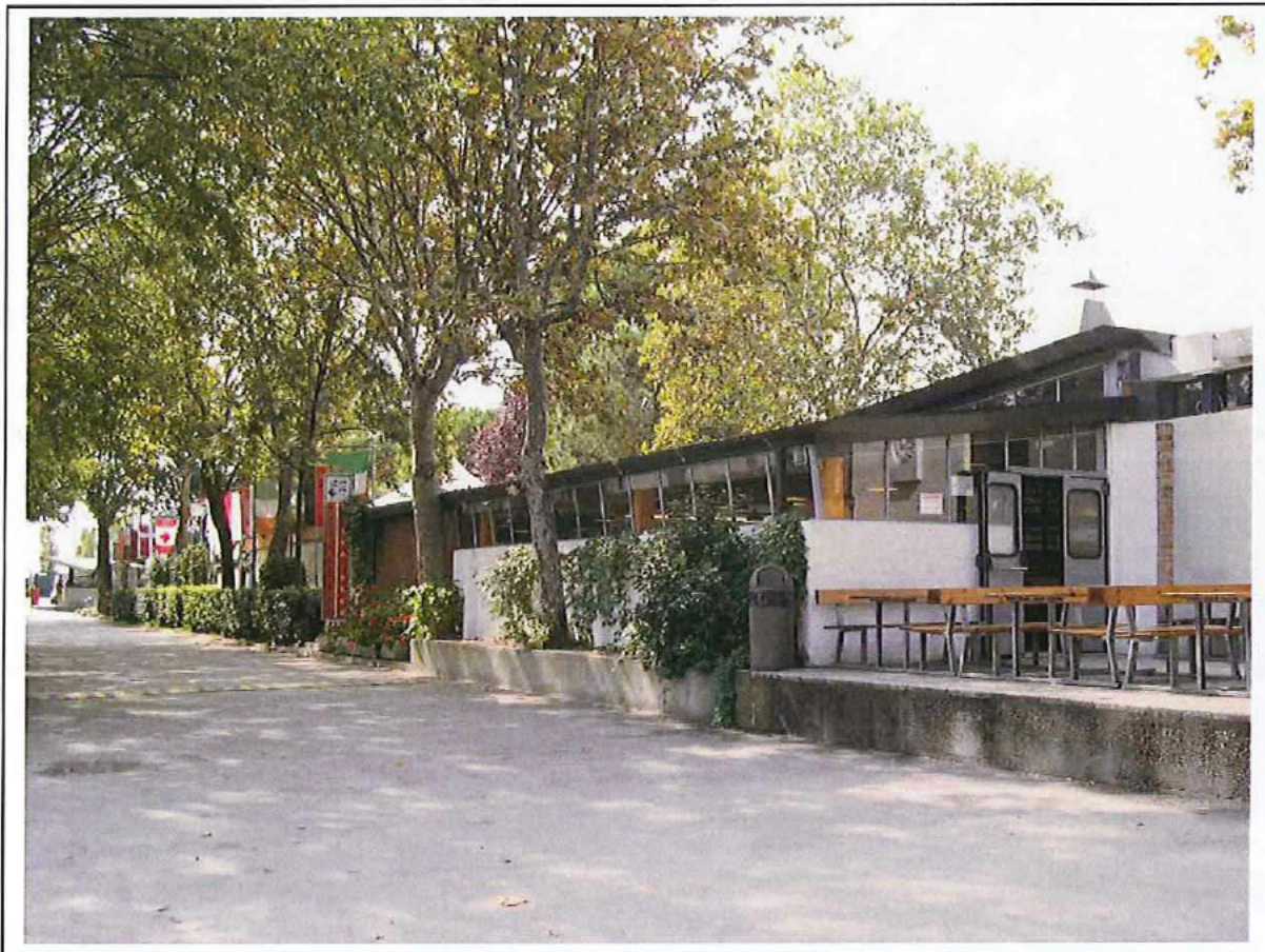
STRUTTURA BAR-RISTORANTE CAMPEGGIO n. 7 cono 9
