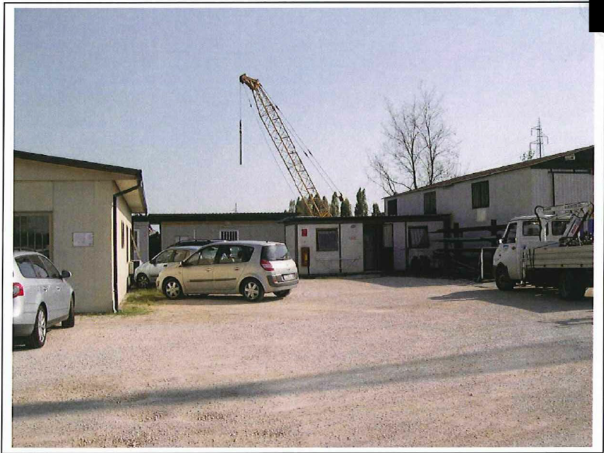
CAPANNONI n. 22 cono 4
