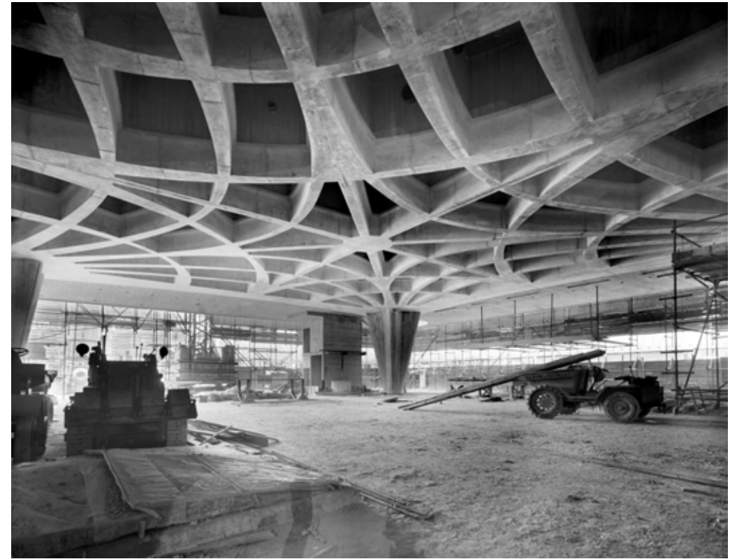
Venezia, Cassa di Risparmio, Campo Manin, stato lavori - 1970
