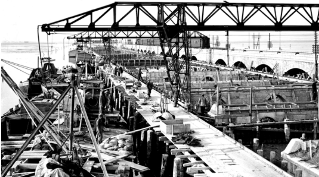
Ferrobeton, laguna di Venezia, costruzione del Ponte della Libertà - 1932
