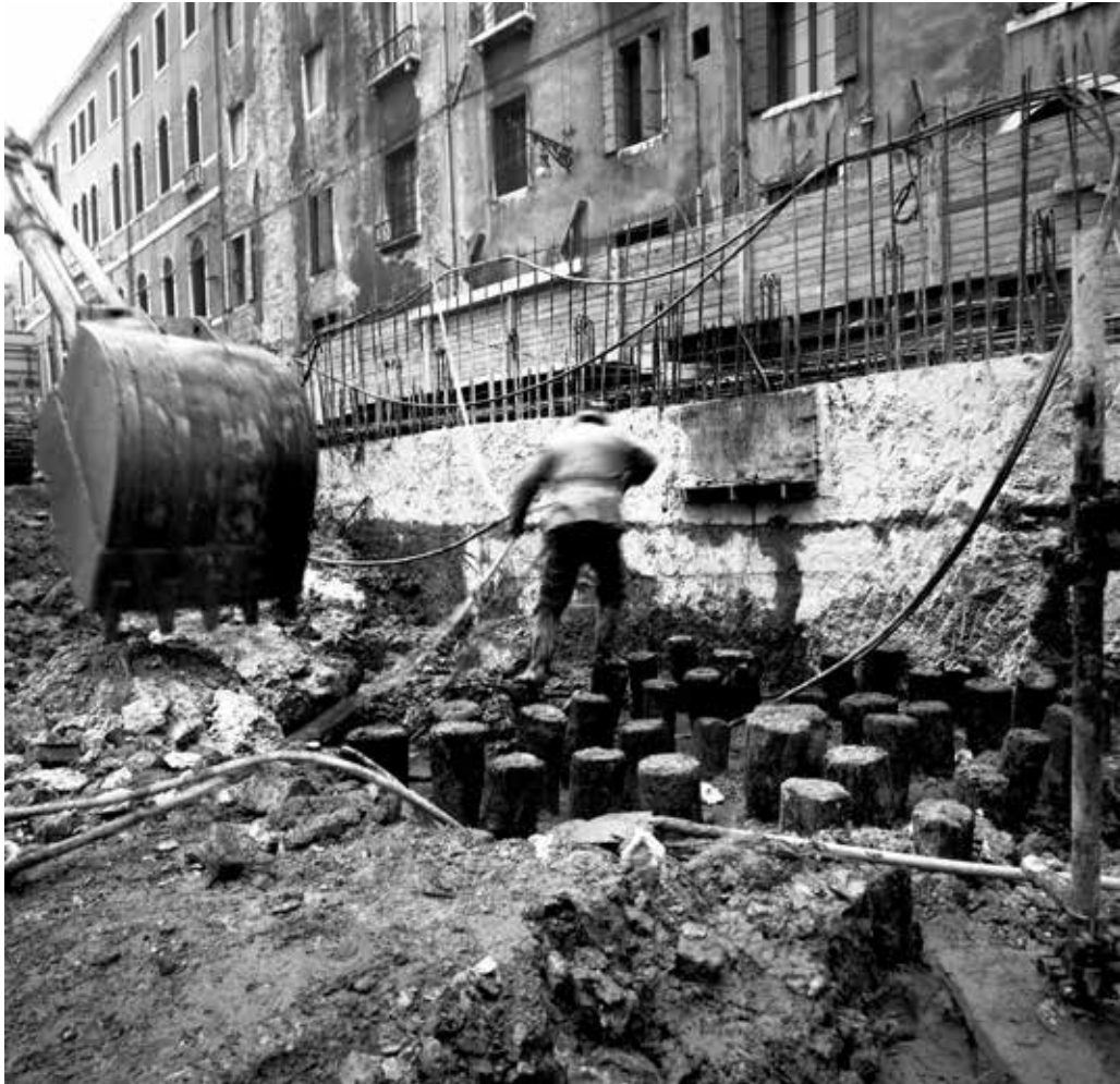
Venezia, Cassa di Risparmio, Campo Manin, stato lavori - 1968
