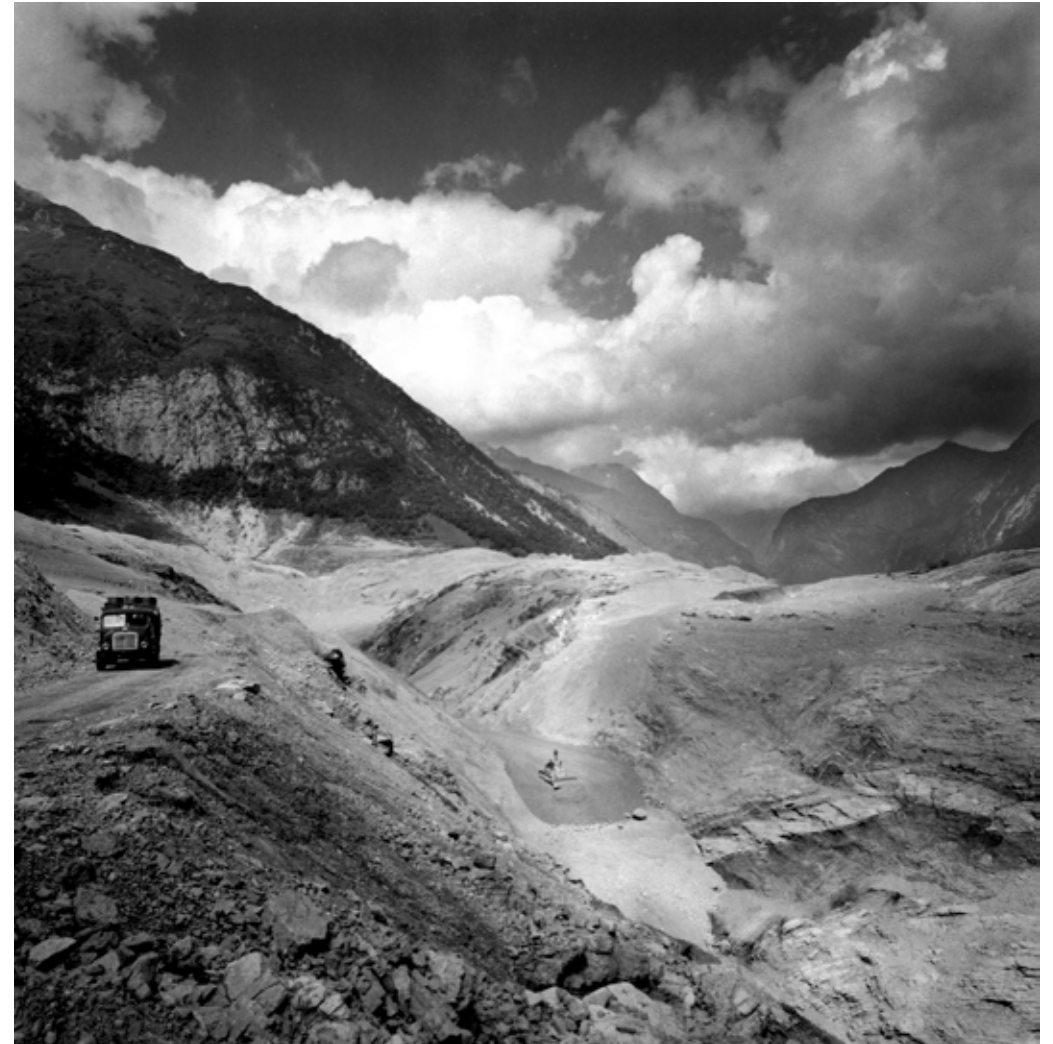
Vajont, lavori per la diga del Vajont - 1964
