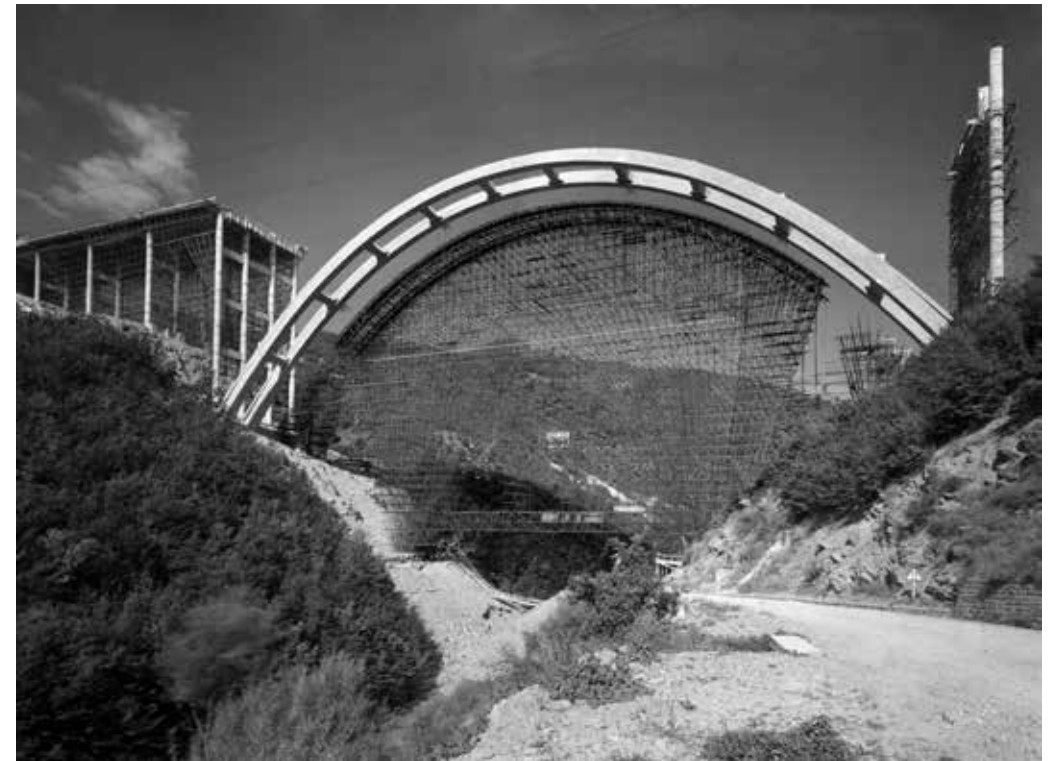
Autostrada del Sole, costruzione Viadotto Gambellato, Castigione dei Pepoli, Bologna -1959
