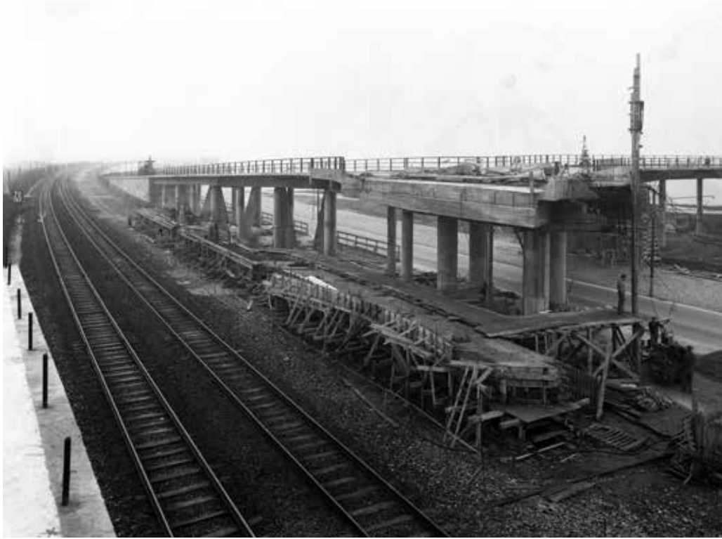
Mestre, San Giuliano, costruzione del cavalcavia - 1955
