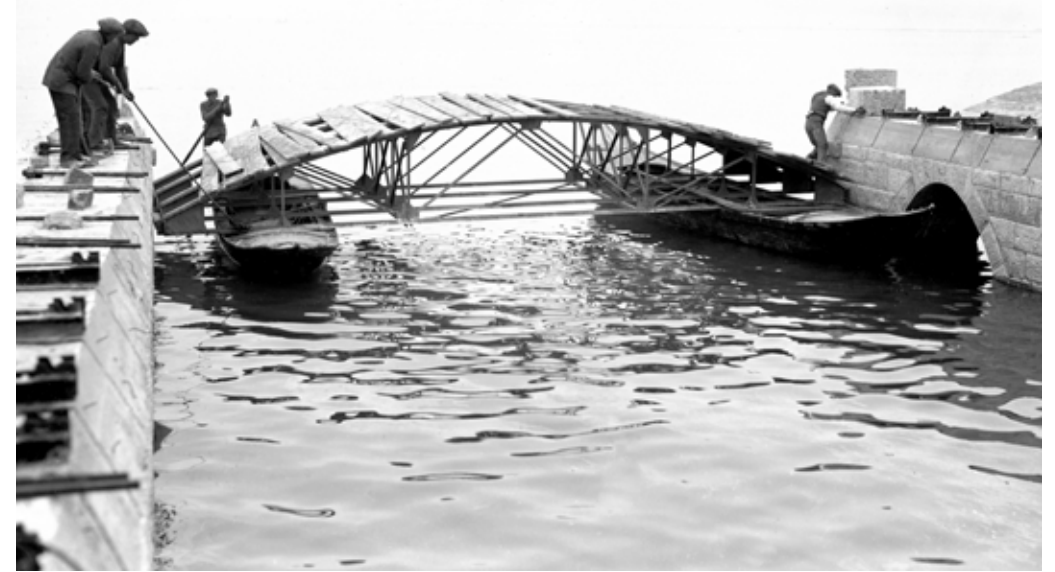
Ferrobeton, laguna di Venezia, costruzione del Ponte della Libertà. Posizionamento Struttura per costruzione di un'arcata - 1932
