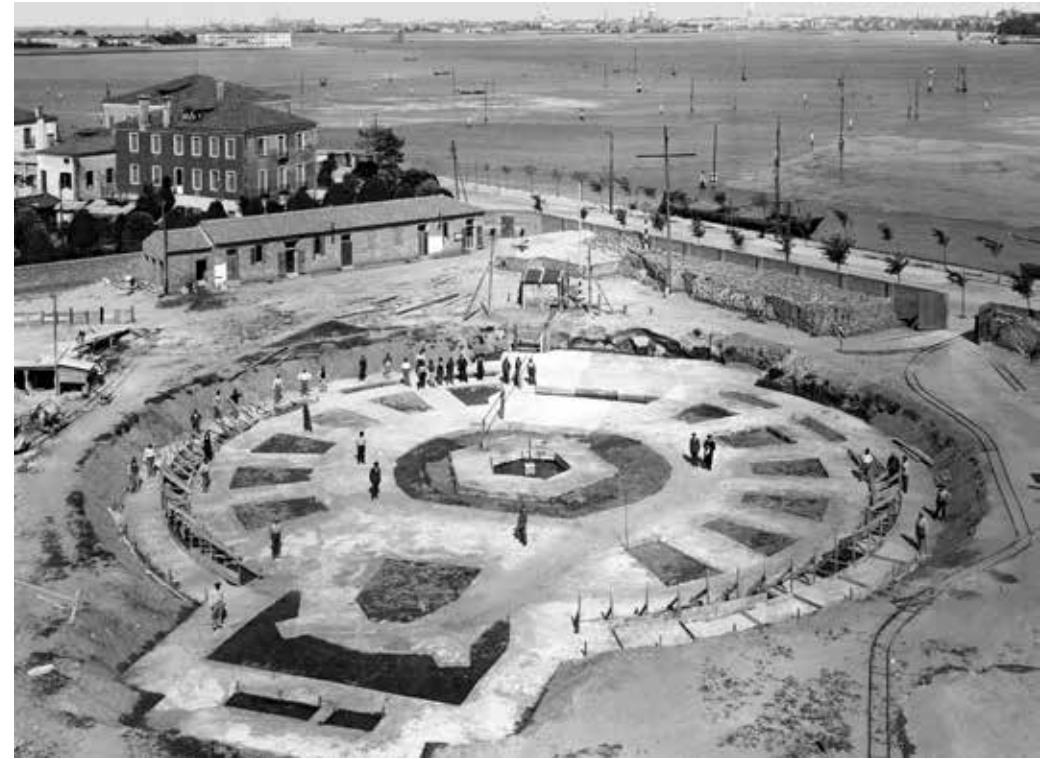
Lido di Venezia, costruzione del Tempio Votivo, il cantiere verso la laguna - 1926
