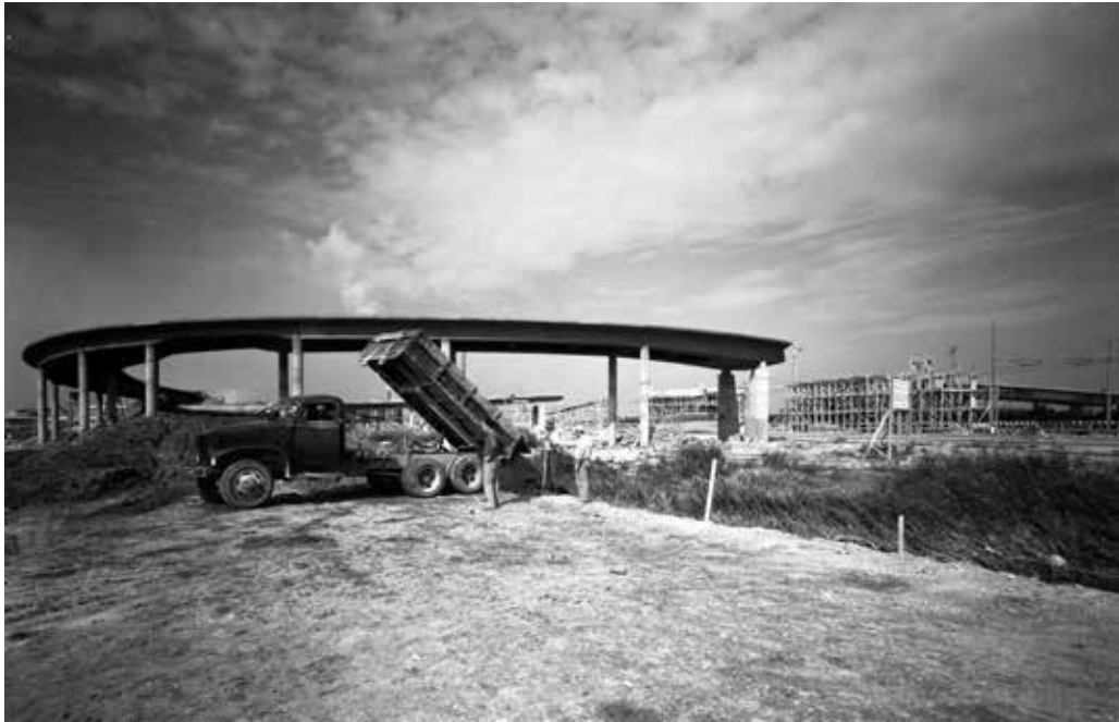
Mestre, San Giuliano, costruzione del cavalcavia - 1954
