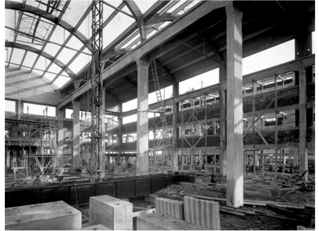
Venezia, Marghera, SCAIM cantiere costruzione dell'impianto Montecatini per la lavorazione dello zinco a Marghera - 1935
