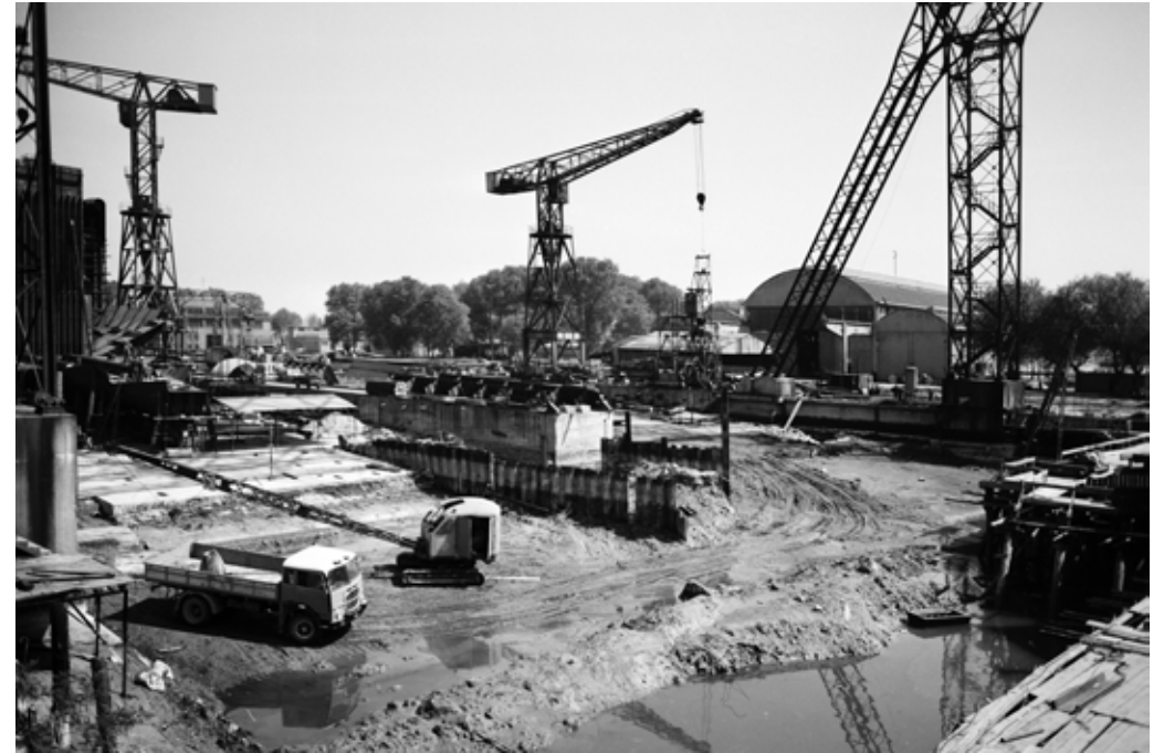
Porto Marghera, cantiere Breda, lavori costruzione scalo - 1966
