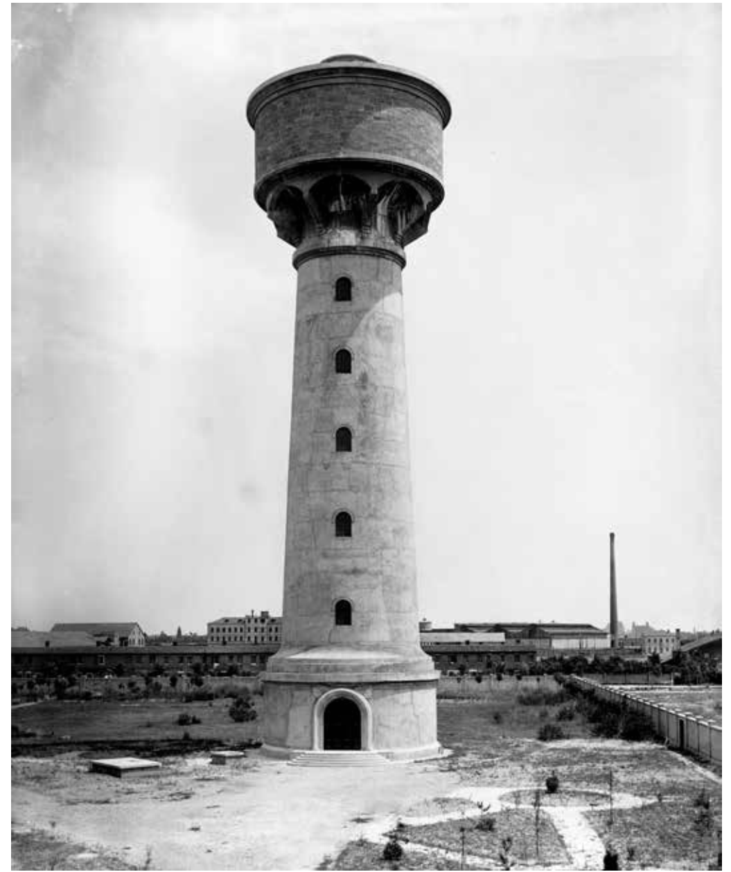
Marghera, costruzione dell'acquedotto, la torre - 1929
