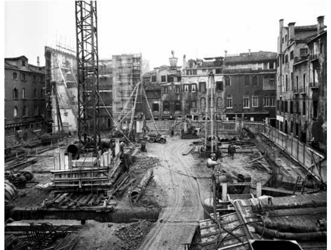
Venezia, Cassa di Risparmio, Campo Manin, stato lavori - 1968
