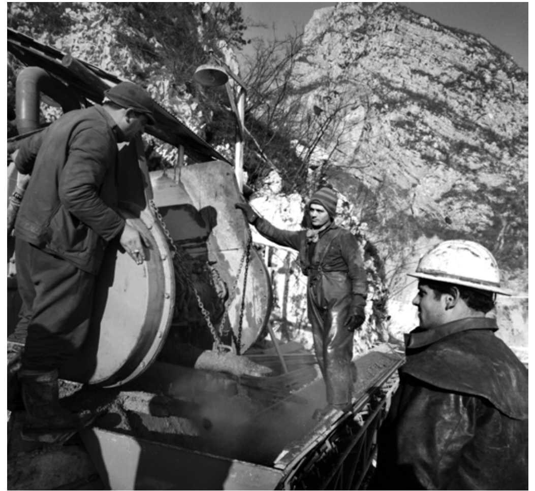
Vajont, SADE, lavori per la diga del Vajont - 1964
