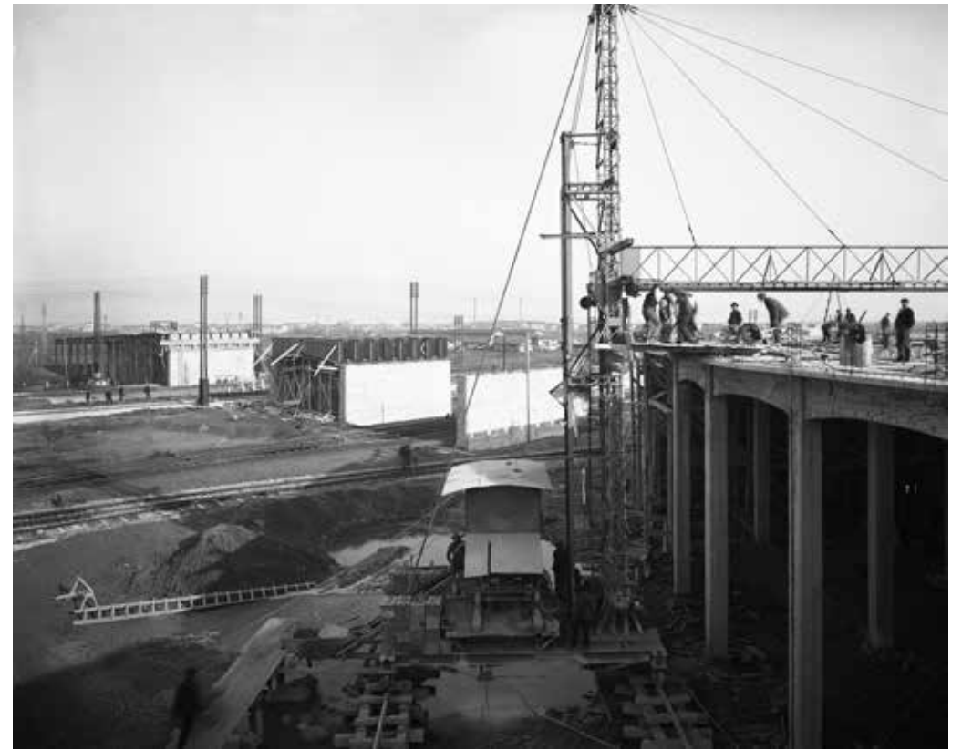
Mestre, costruzione del cavalcavia, il cantiere - 1928
