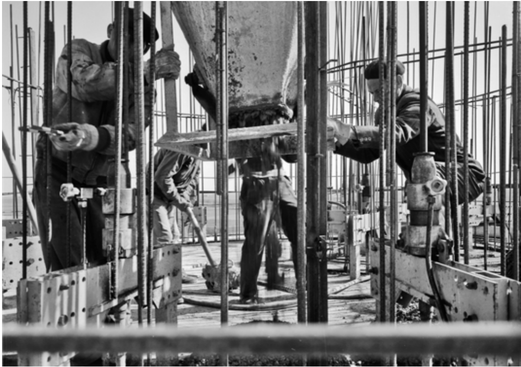
Jolanda di Savoia, operai addetti alla costruzione della torre di sollevamento dell'acquedotto - 1966
