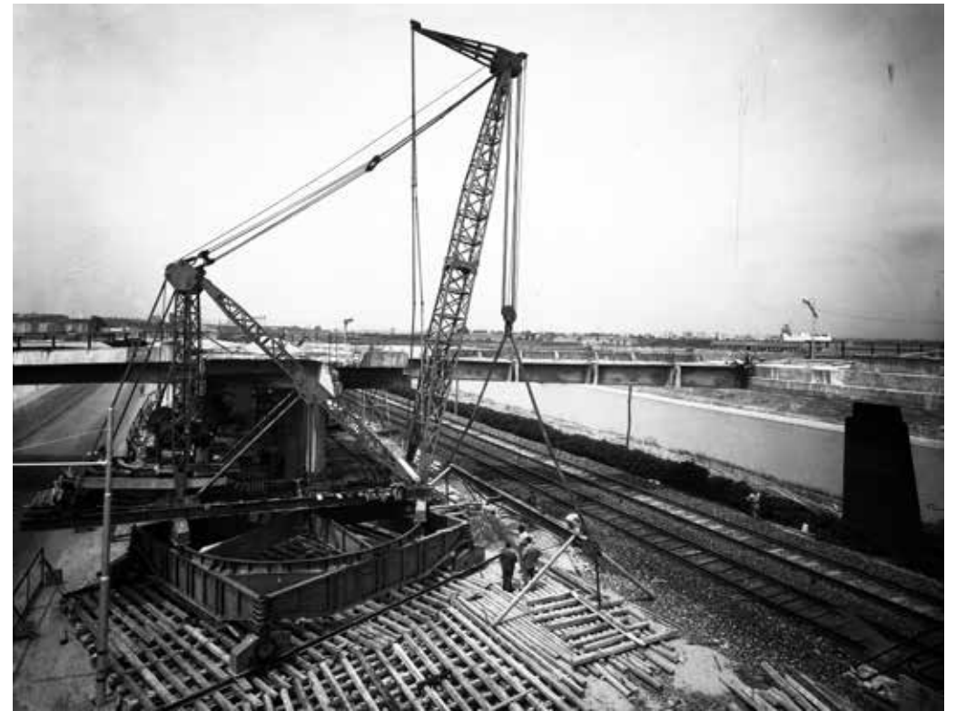
Mestre, San Giuliano, costruzione del cavalcavia - 1955
