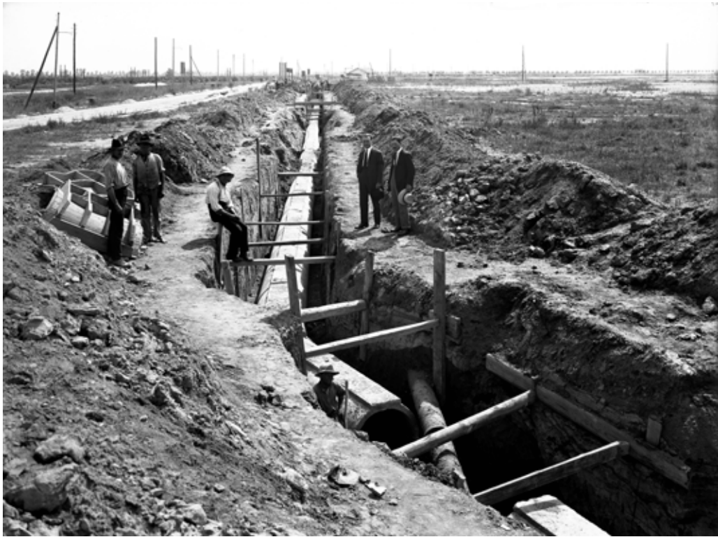
Marghera, costruzione dell'acquedotto, posa di una tubatura - 1923
