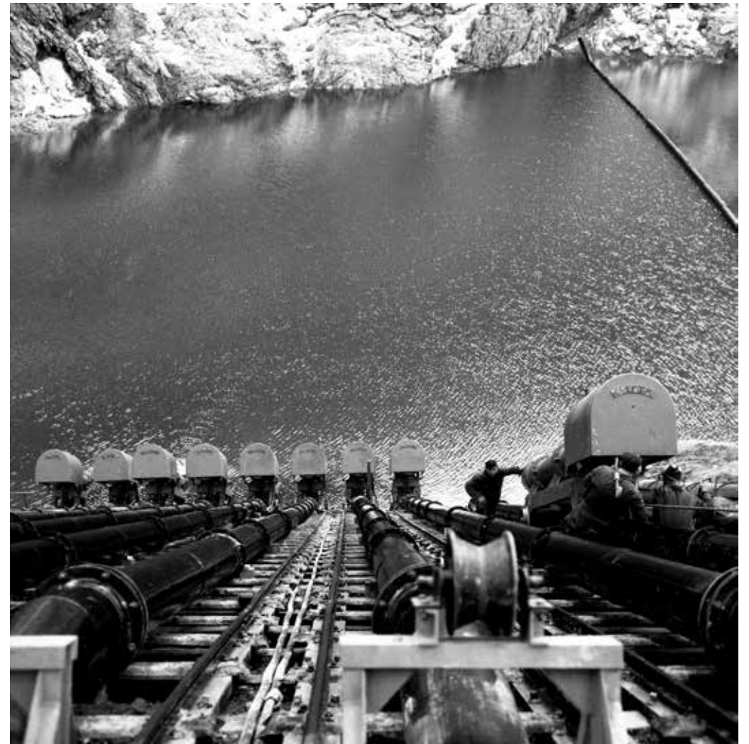
Vajont, SADE-ENEL, lavori per la diga del Vajont - 1964
