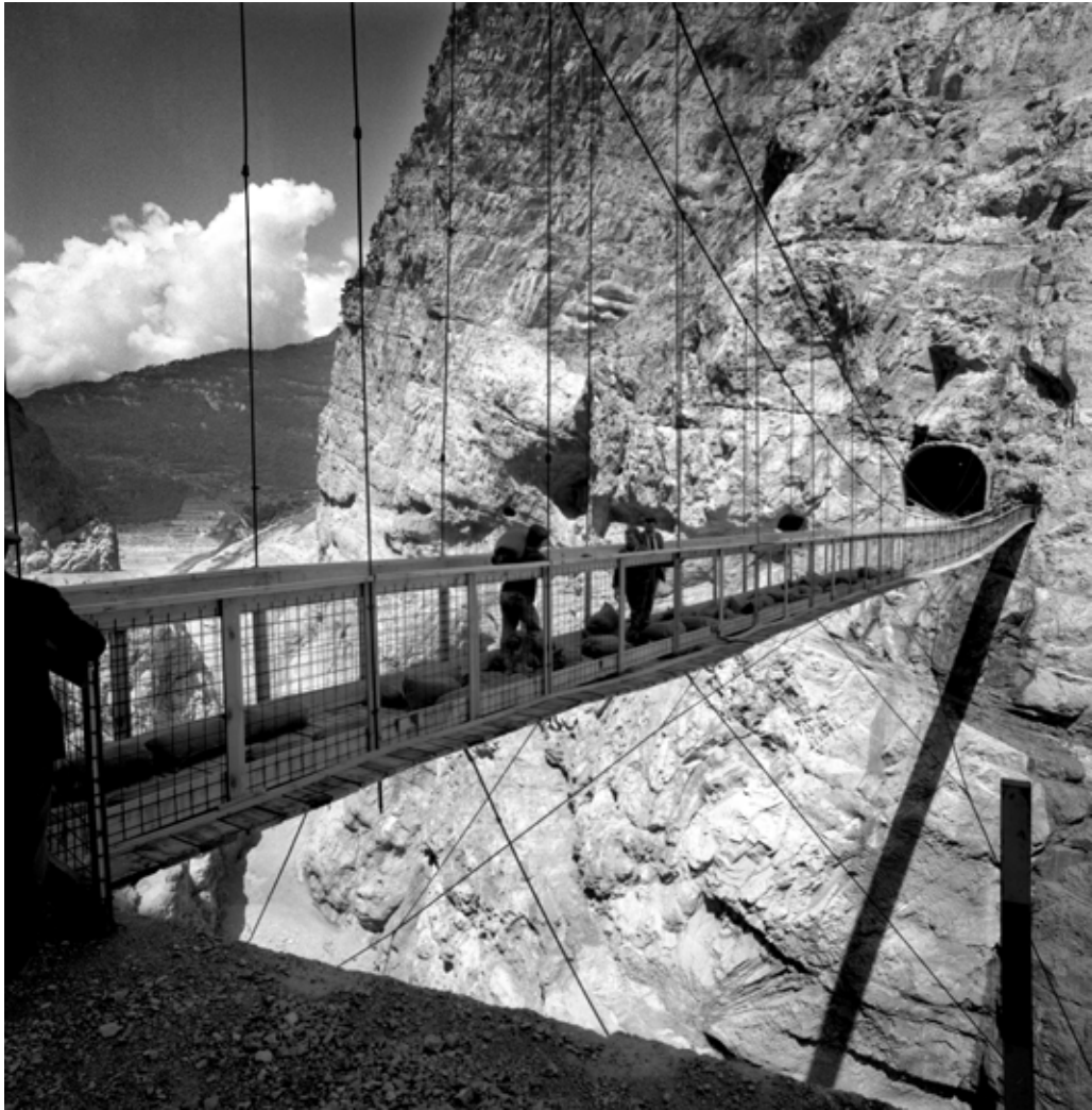
Vajont, lavori per la diga del Vajont - 1964
