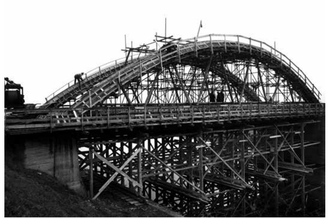
Padova, Provincia di Padova, cantiere costruzione ponte - 1961
