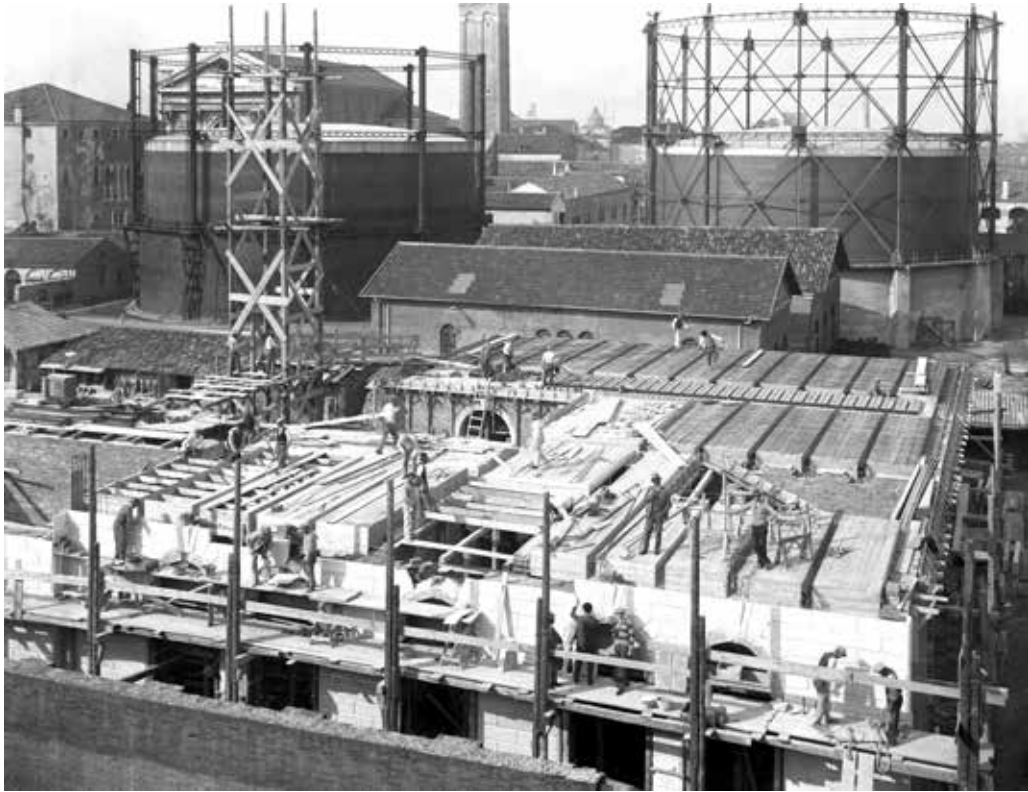
Venezia, Regio Istituto Paolo Sarpi, costruzione, il cantiere verso i gasometri - 1930
