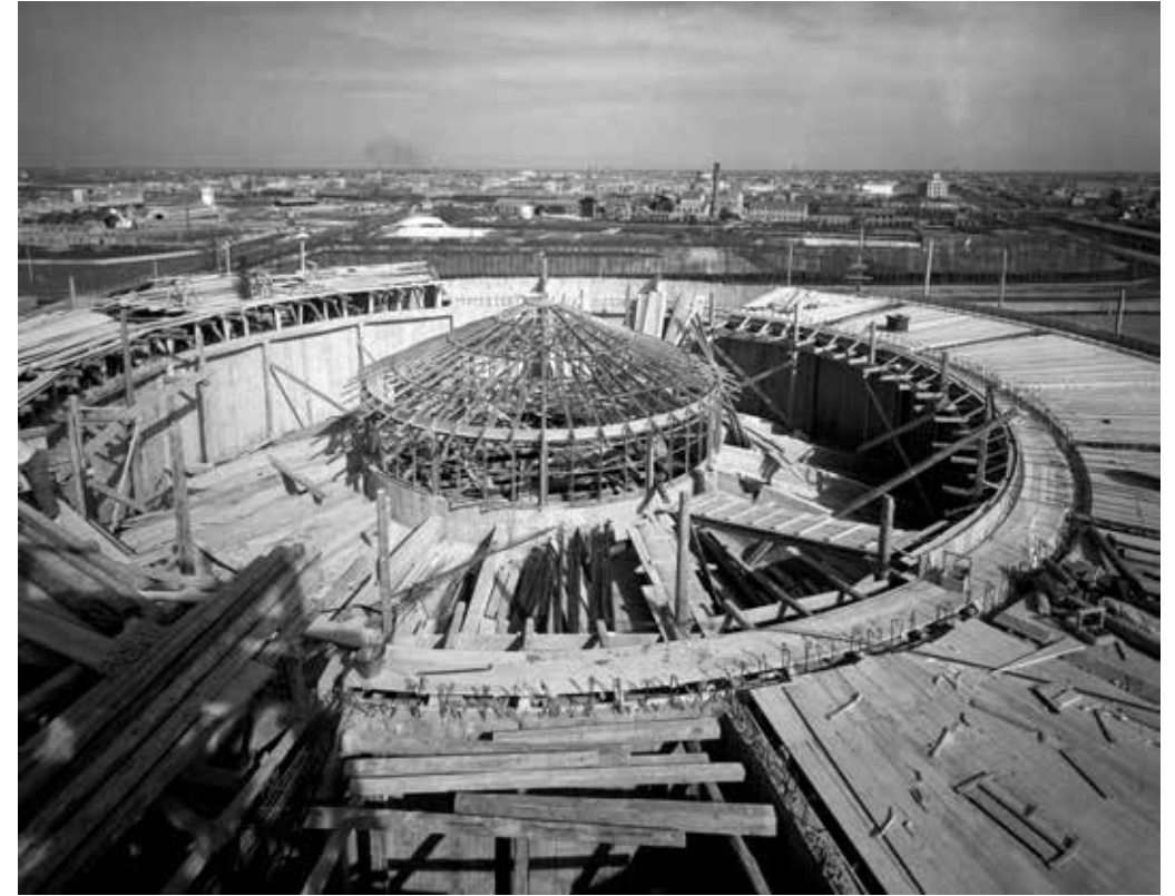
Ferrara, costruzione di uno stabilimento Montecatini - 1952
