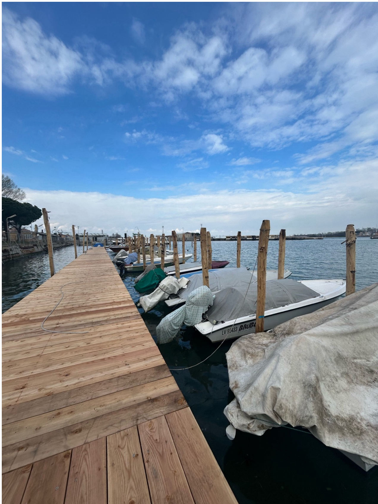
Completamento dei lavori del pontile in legno marzo 2025
