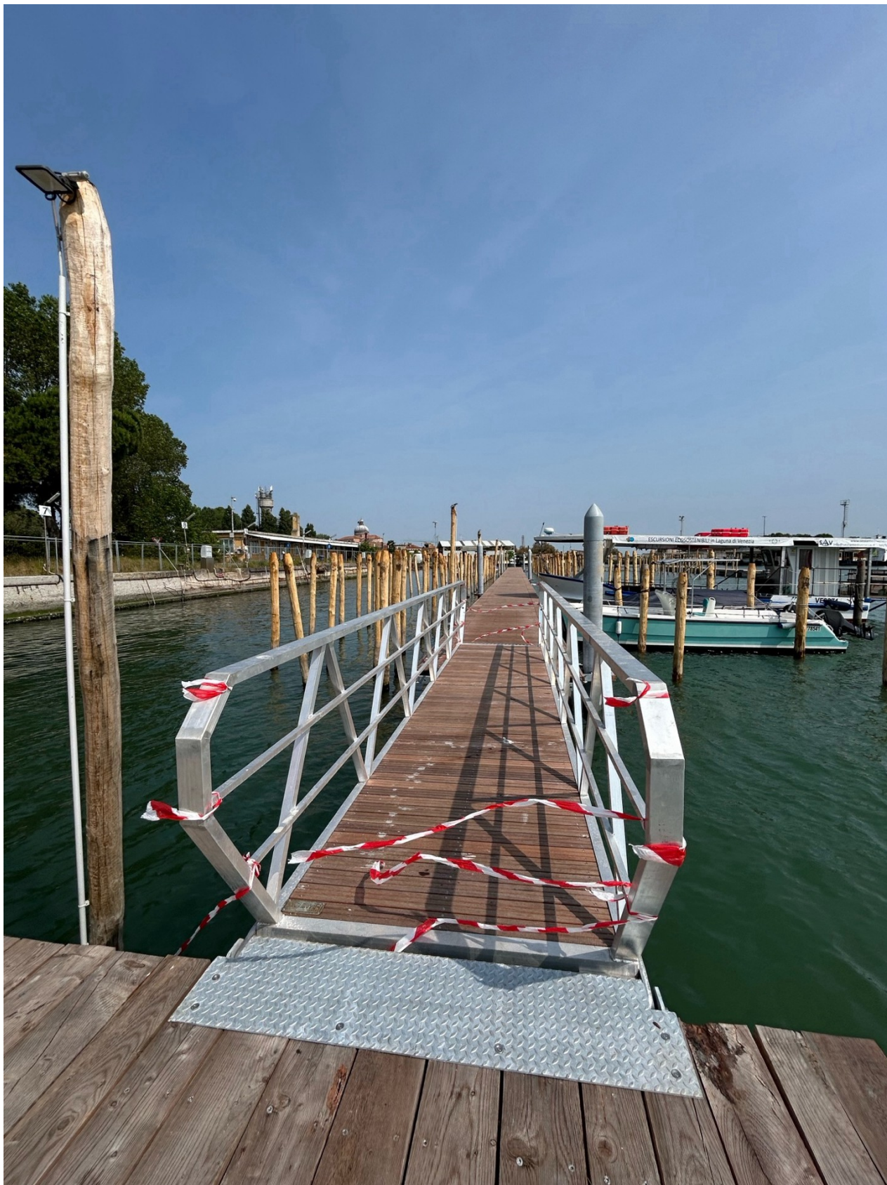
Completamento accessori pontile galleggiante giugno 2025
