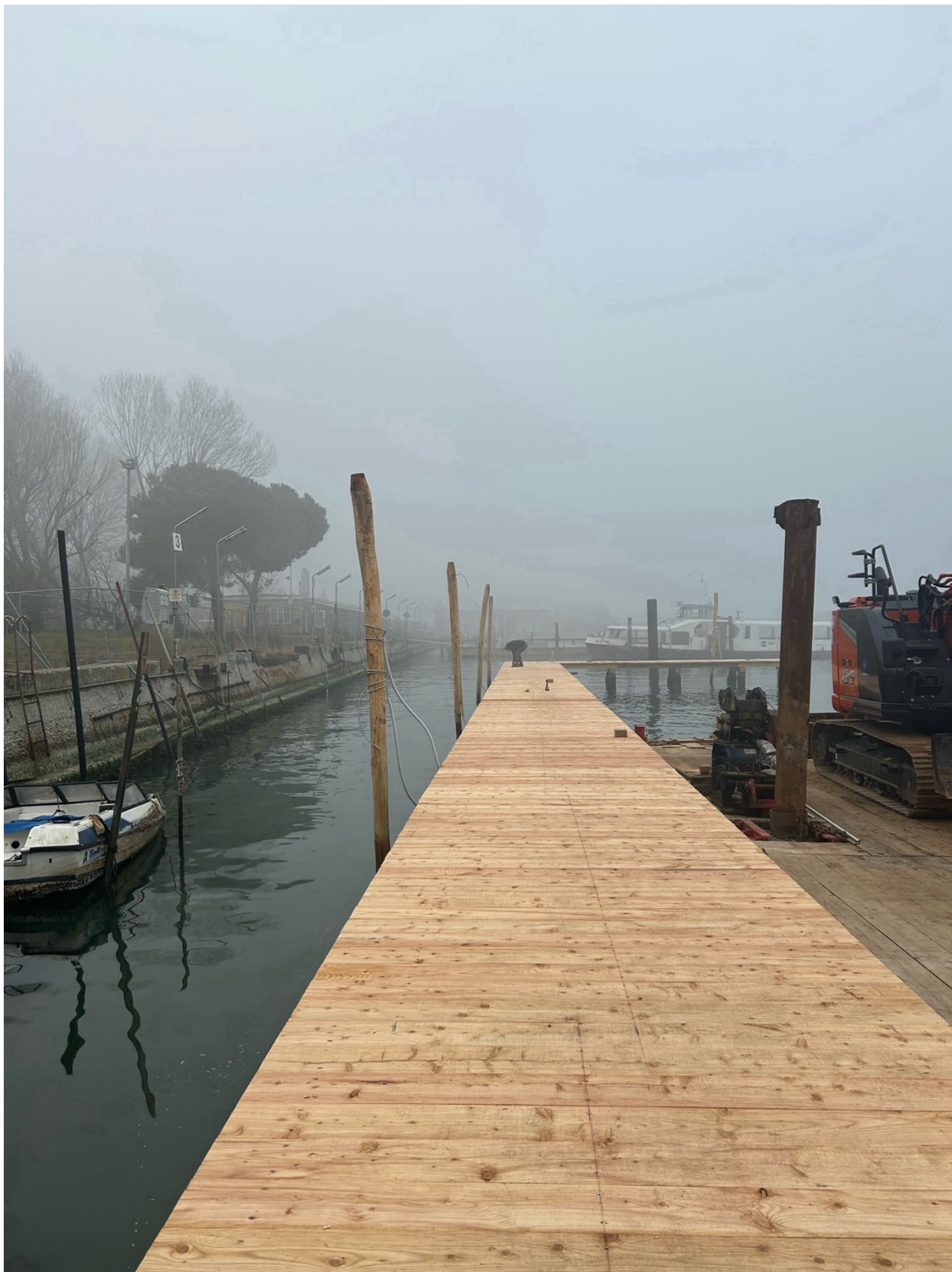
Esecuzione piano di calpestio del pontile in legno febbraio 2025
