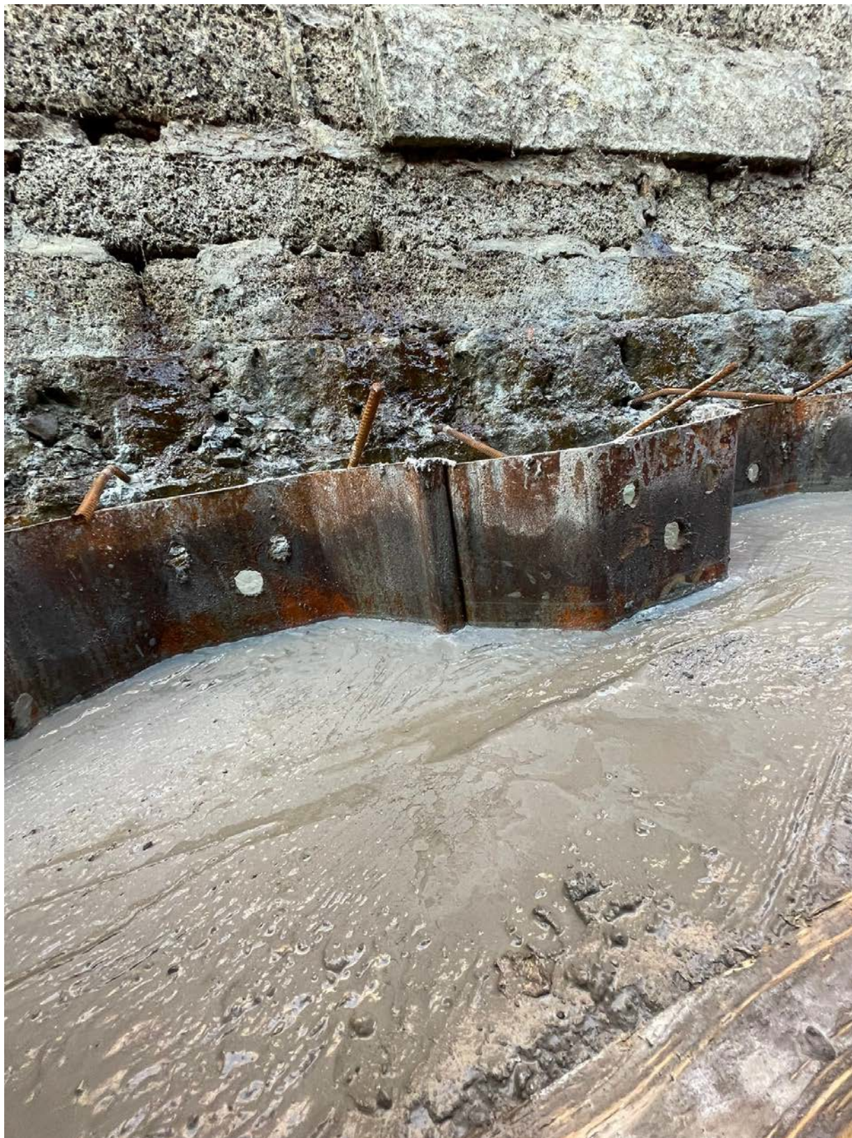
Intervento di esecuzione foro palancola non previsto da progetto esecutivo
