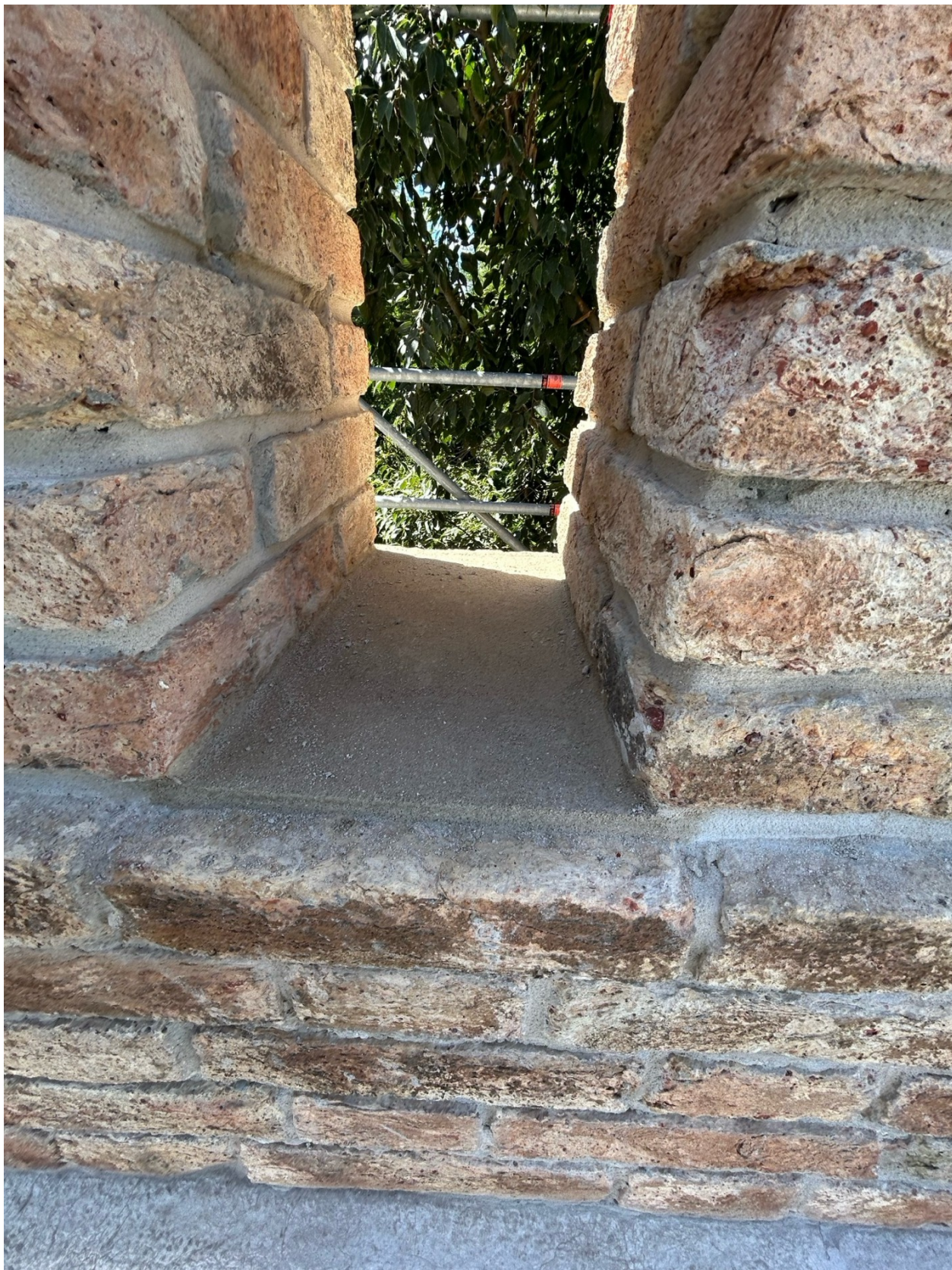
Intervento protezione con copertina a base calce e protettivo finale per l'idrorepellenza
