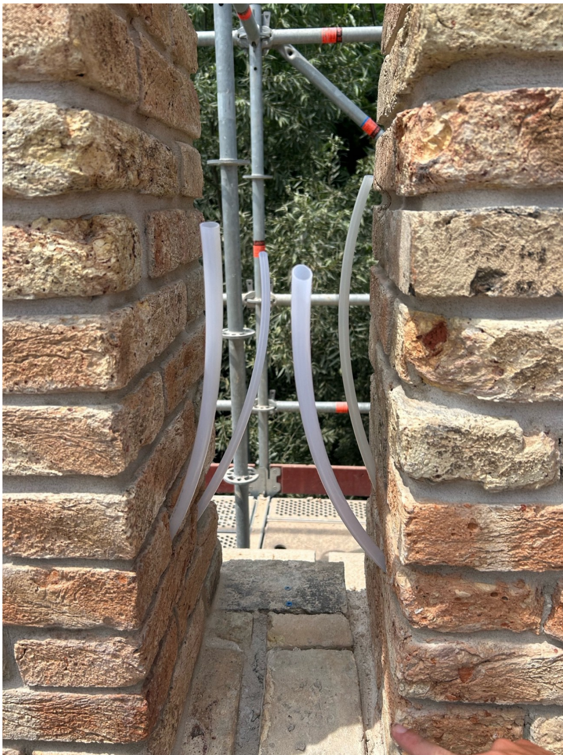
Intervento di consolidamento merli mediante iniezione di malta.
