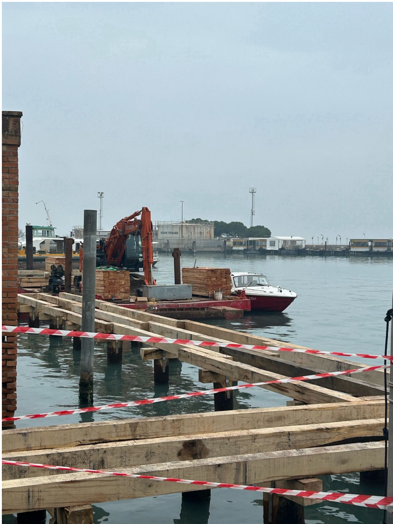
Montaggio struttura in legno del pontile febbraio 2025
