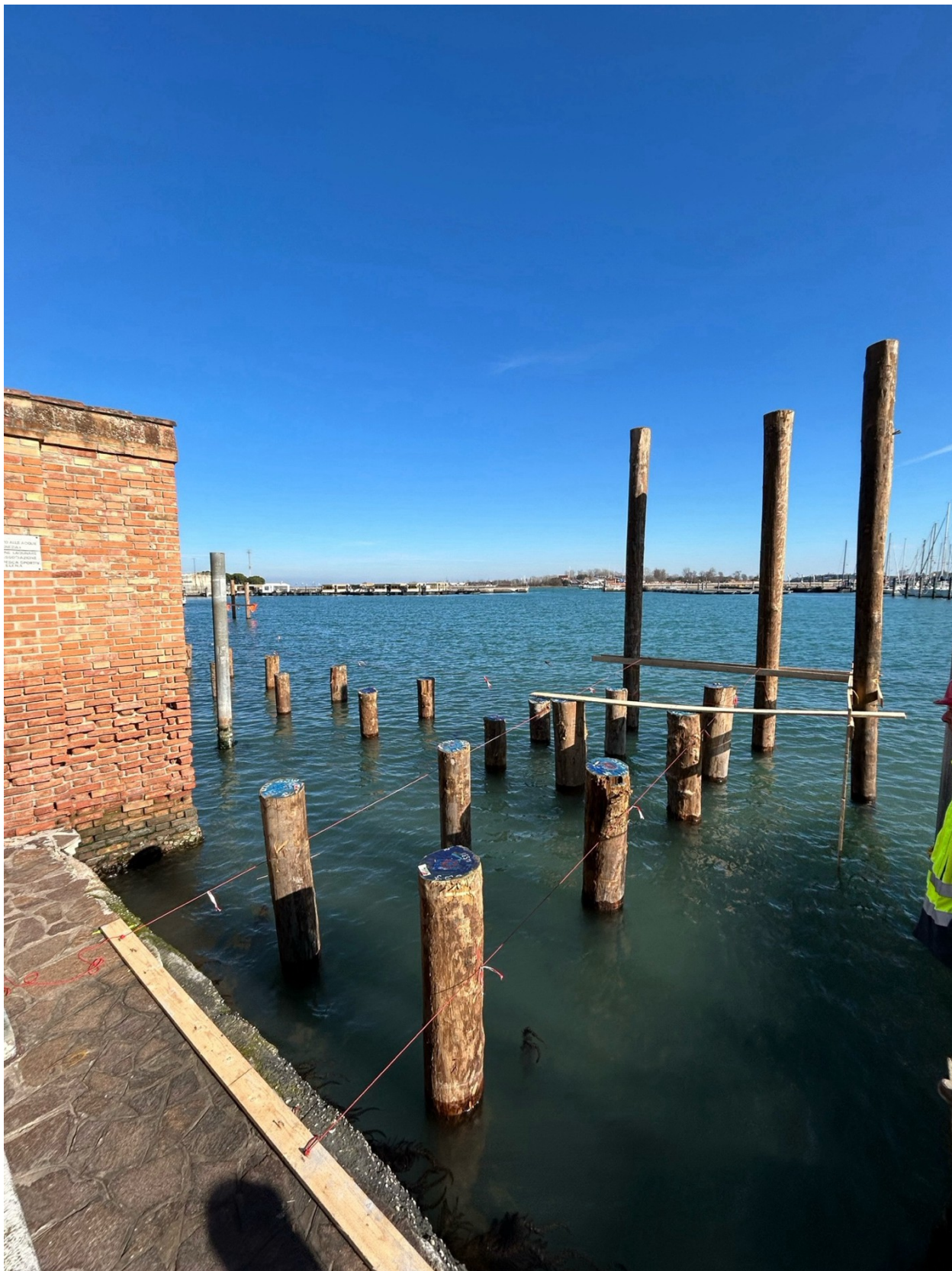
Inizio lavori pontile in legno gennaio 2025
