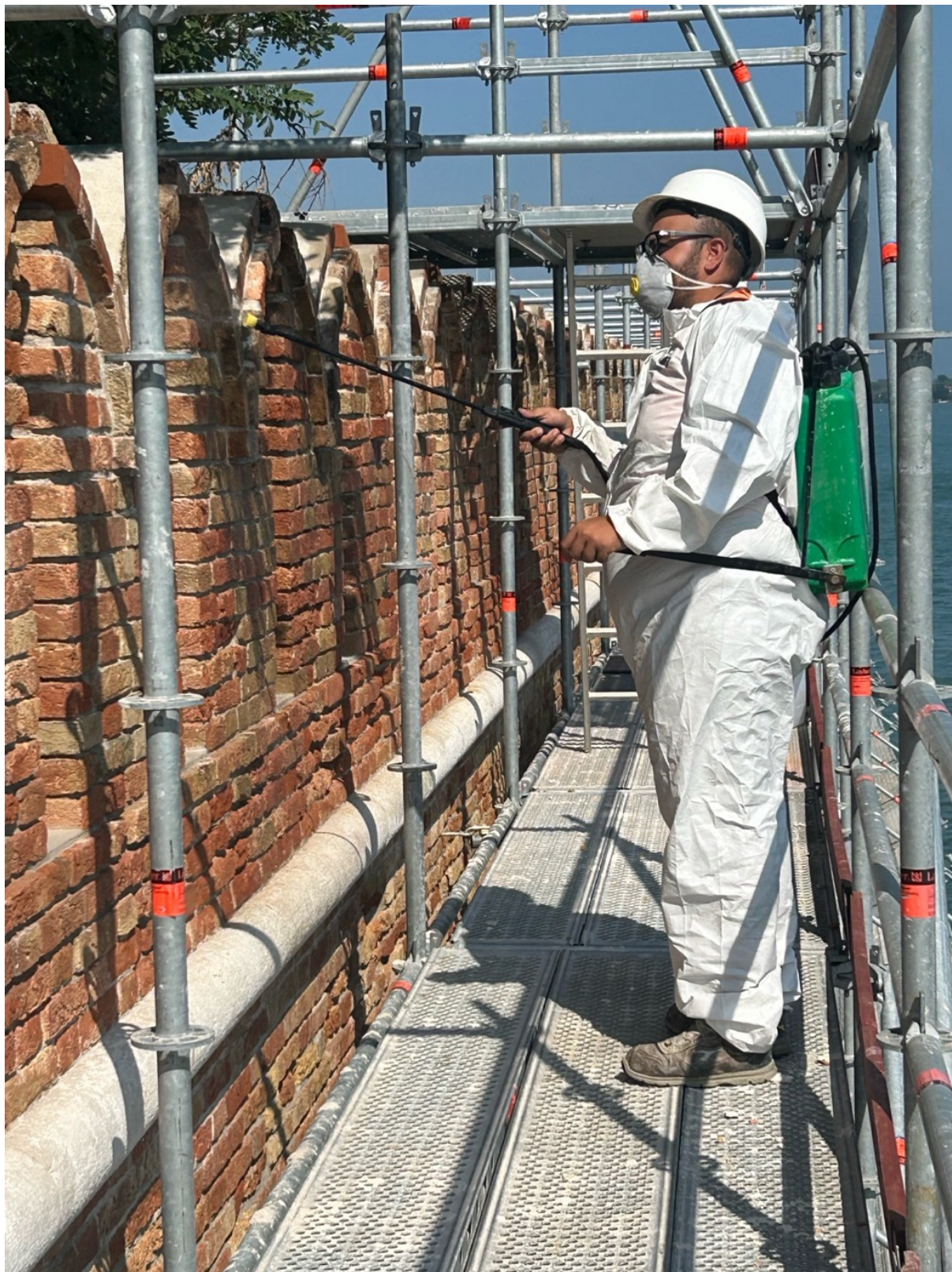
Intervento protettivo finale su paramento murario mediante silossano
