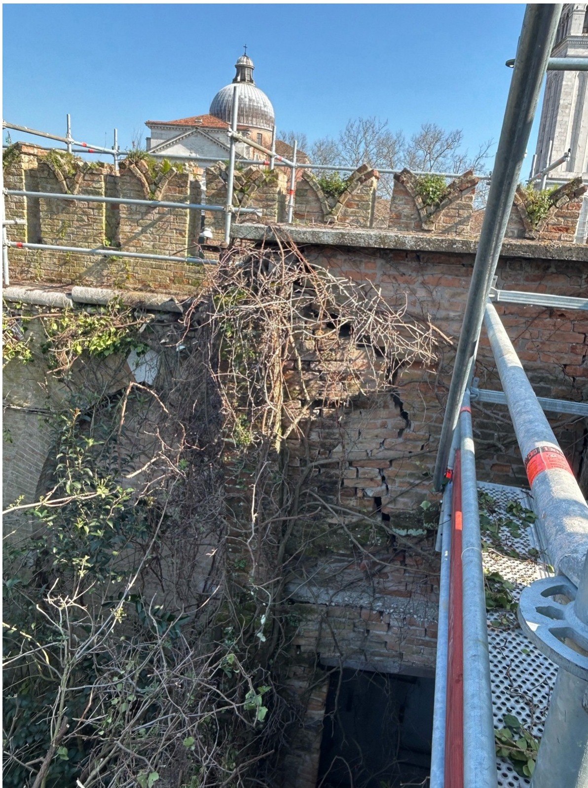
Intervento di smontaggio e recupero materiale di manufatto nel giardino delle Vergini interferente con le lavorazioni del paramento murario e con gravi problemi di stabilità.
