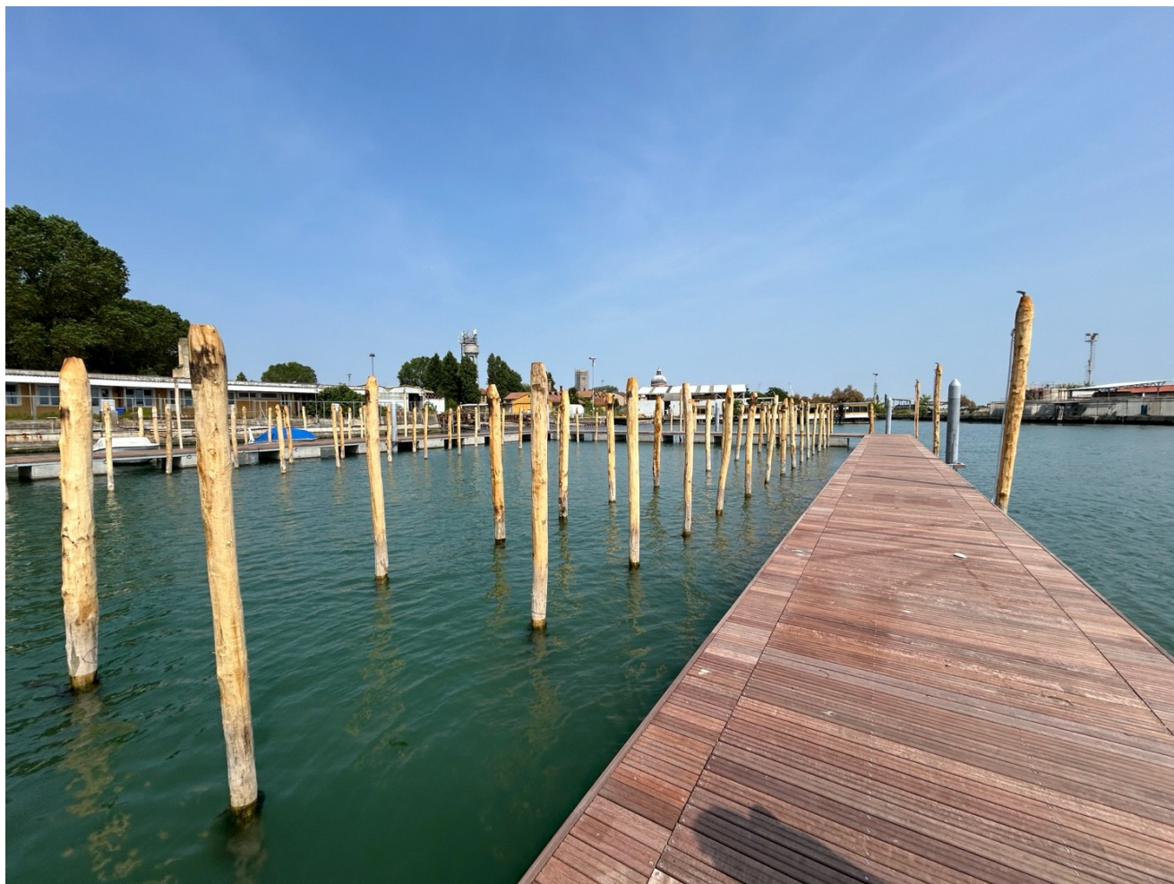
Installazione pontile galleggiante maggio 2025
