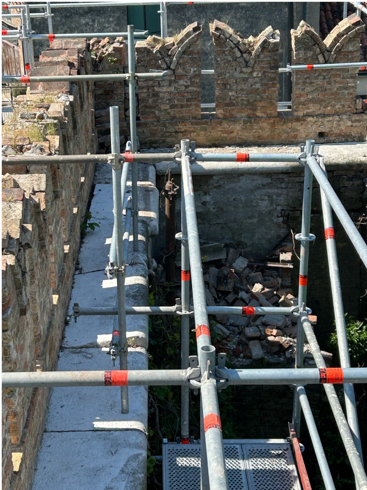
Smontaggio e recupero di materiale del manufatto interno ai giardini delle Vergini di Biennale
