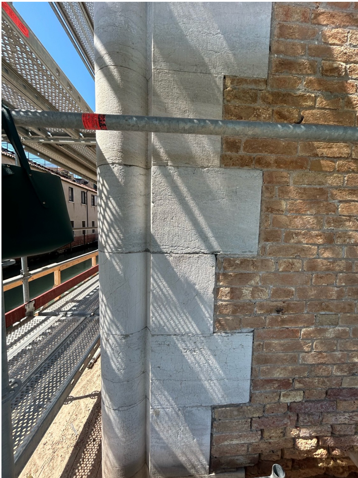
Intervento di pulitura e consolidamento pietra
