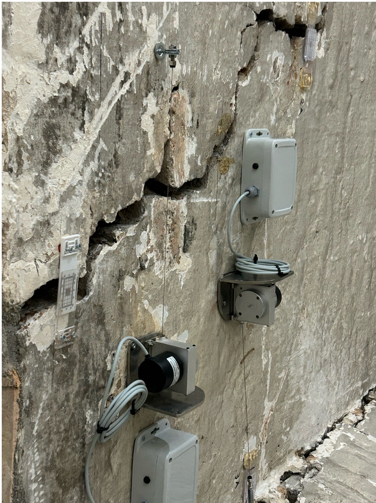
Installazione inclinometro all'interno di Biennale
