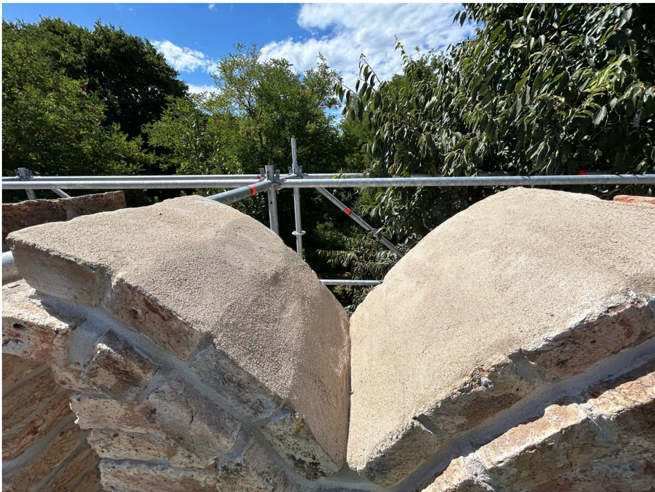
Intervento protezione con copertina a base calce e protettivo finale per l'idrorepellenza
