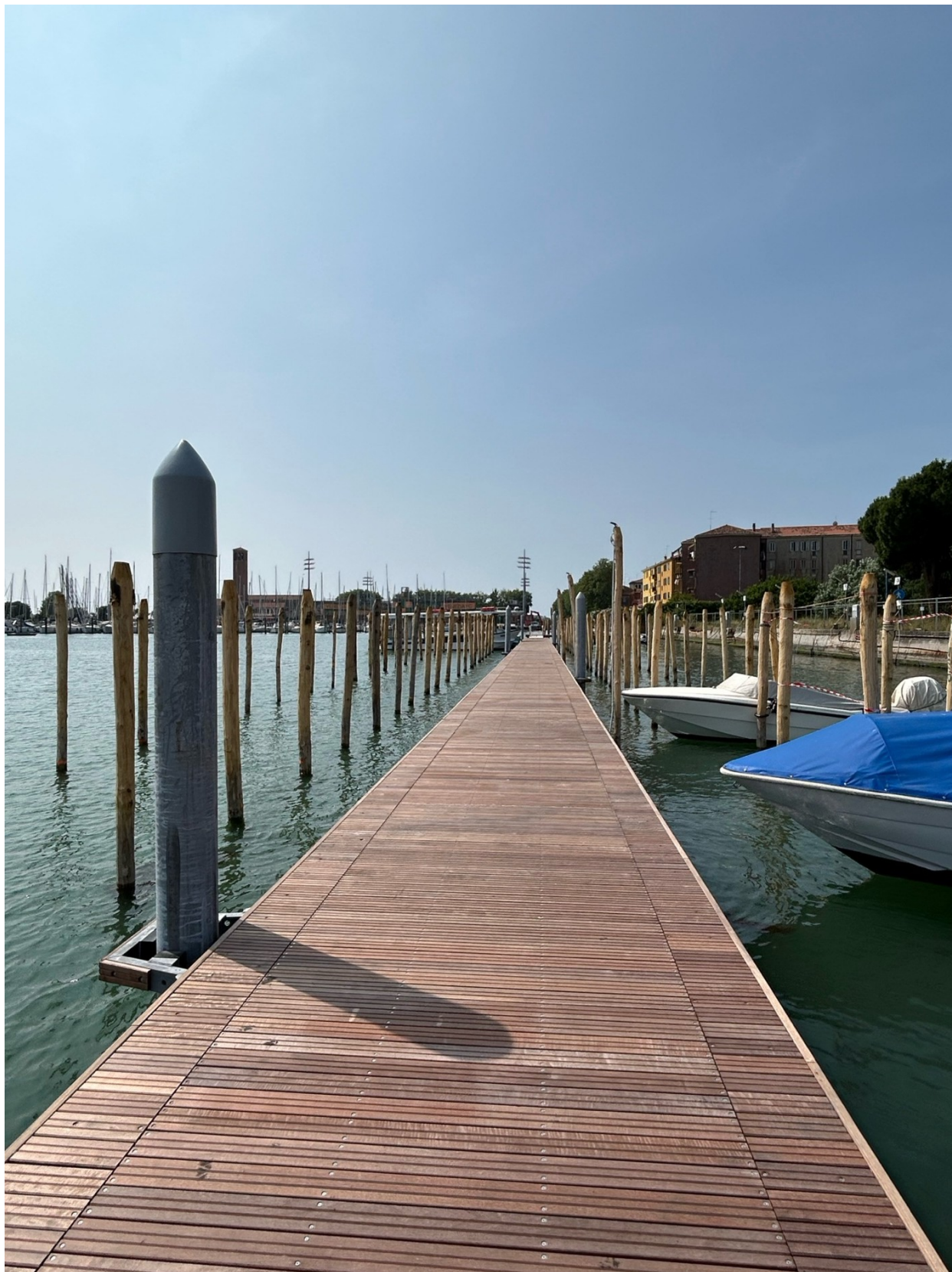
Completamento accessori pontile galleggiante giugno 2025
