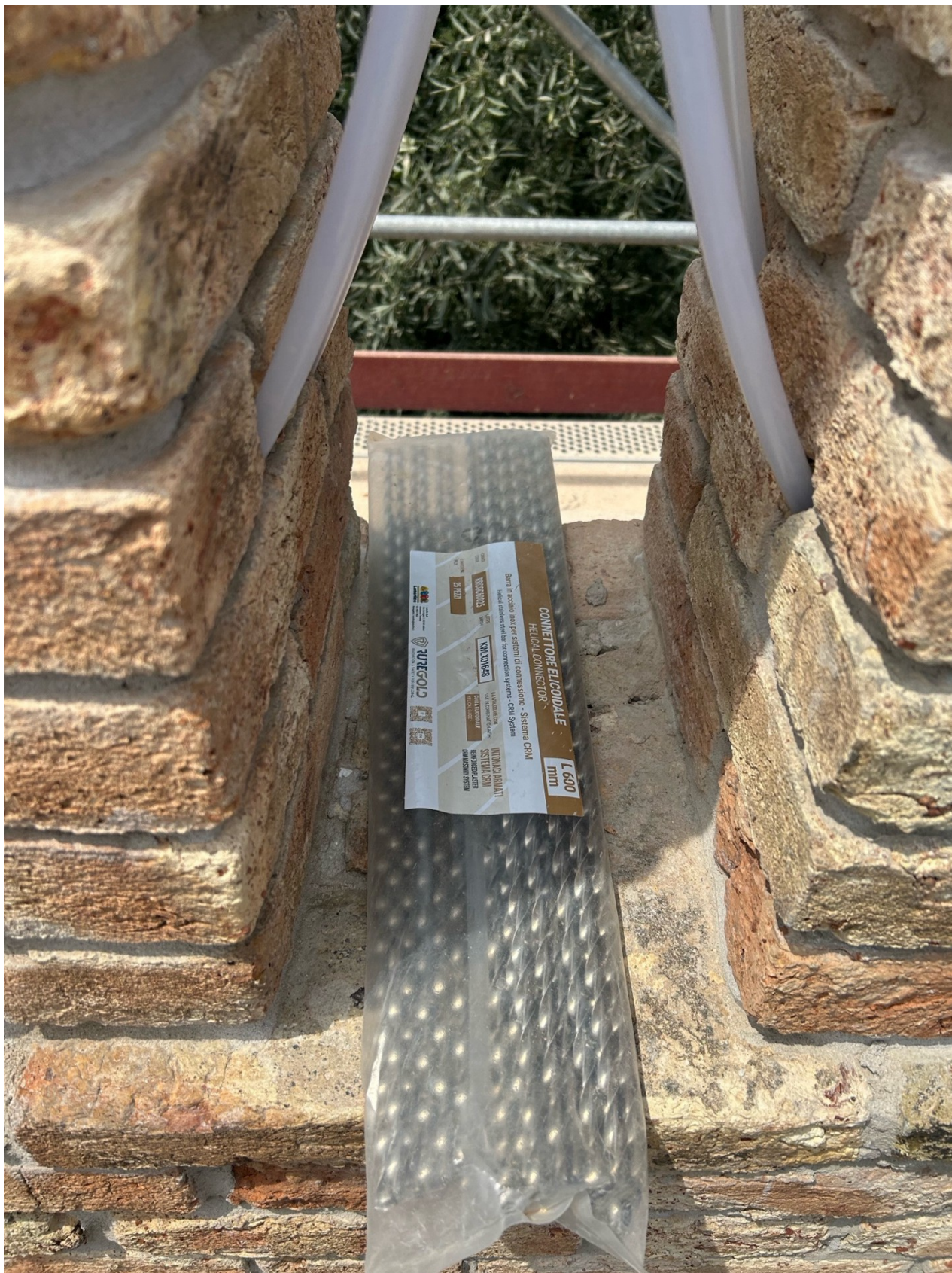
Intervento di consolidamento merli mediante barre filettate e successiva iniezione
