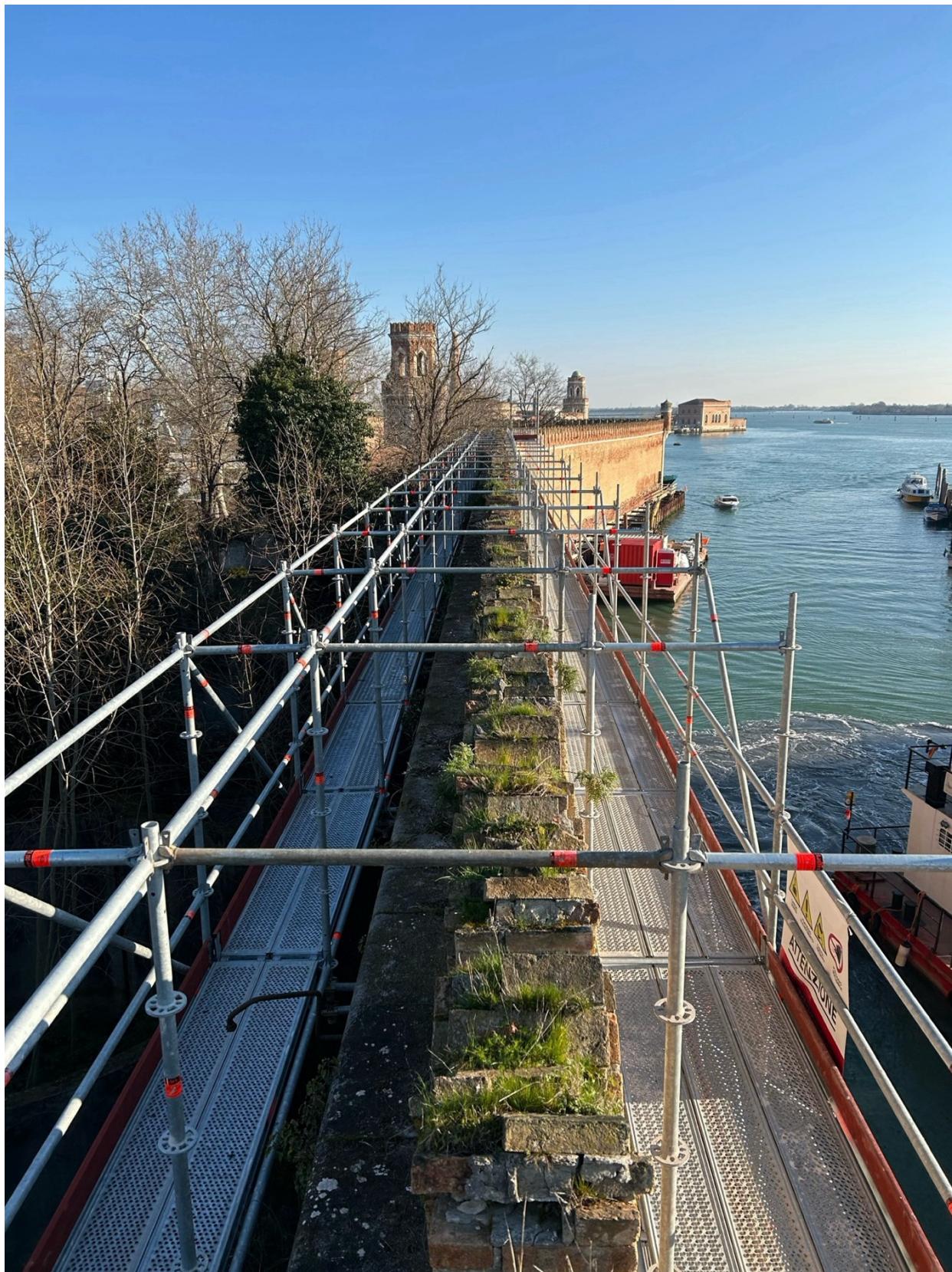
Installazione ponteggio su Canale San Pietro e a scavalco delle merlature
