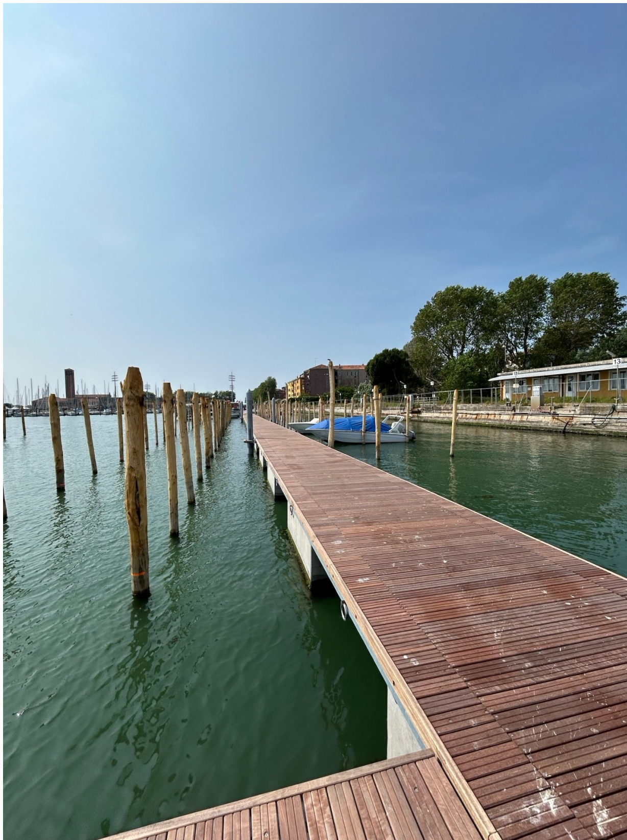
Completamento accessori pontile galleggiante giugno 2025
