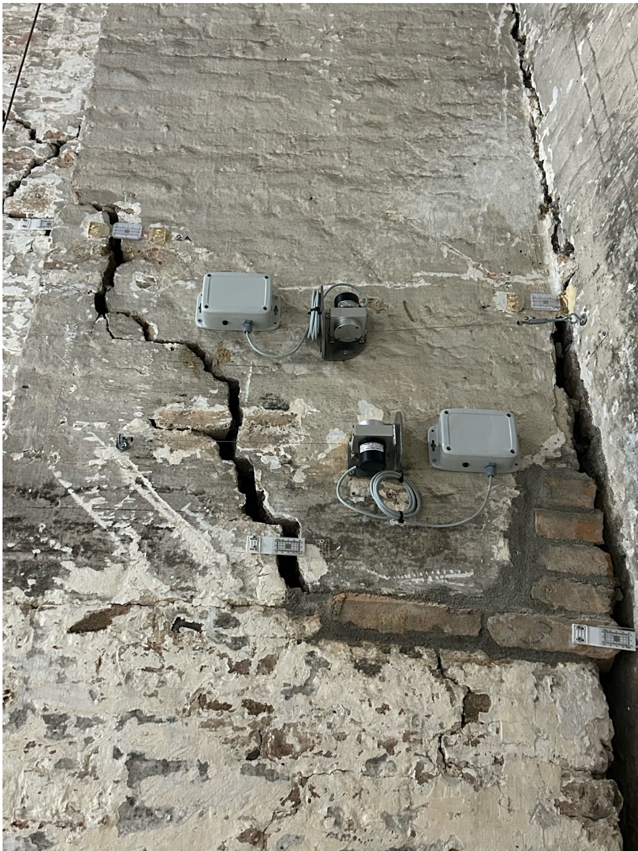
Installazione inclinometro all'interno di Biennale
