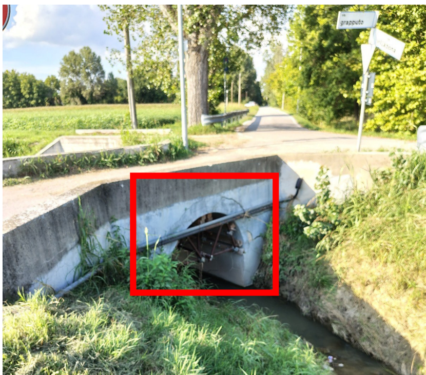
Struttura provvisoria volta
