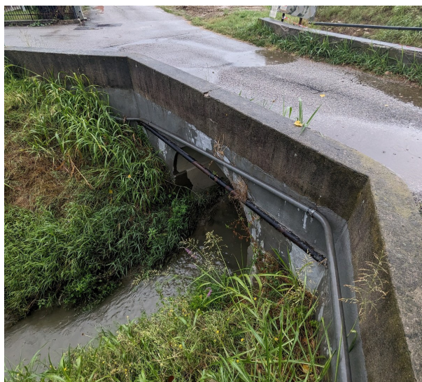
Vista sud ponte esistente
