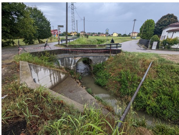
Vista nord ponte esistente
