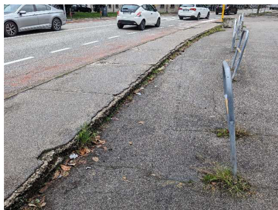
Pavimentazione marciapiede – tratto 1, senza cordonate sul lato interno
