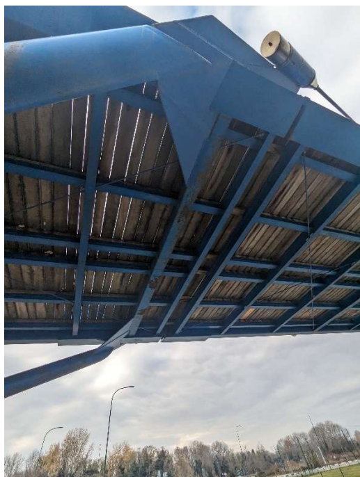
Degrado traverso puntoni lato est
