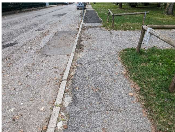
Marciapiede lato nord
