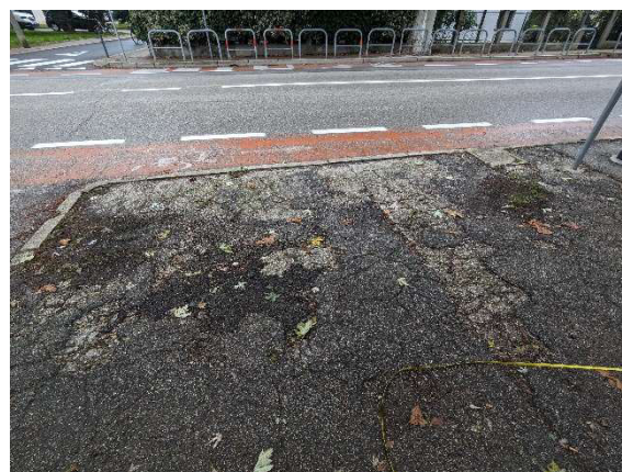
Pavimentazione marciapiede – tratto 2
