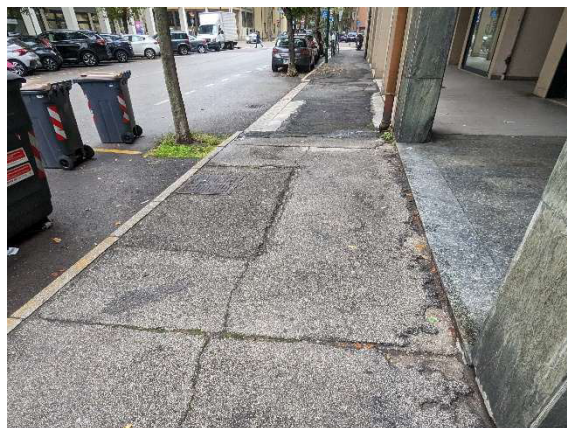
Marciapiede lato nord
