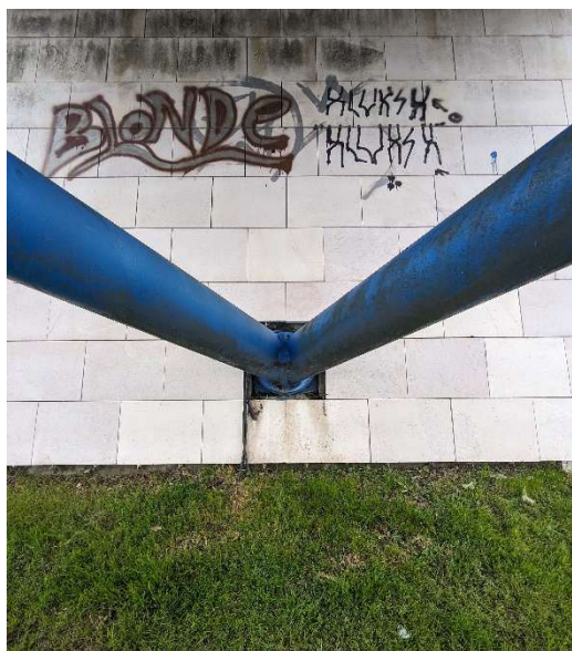
Puntoni inclinati e piastre di appoggio dei puntoni
