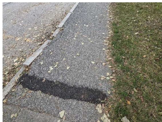
Marciapiede lato nord
