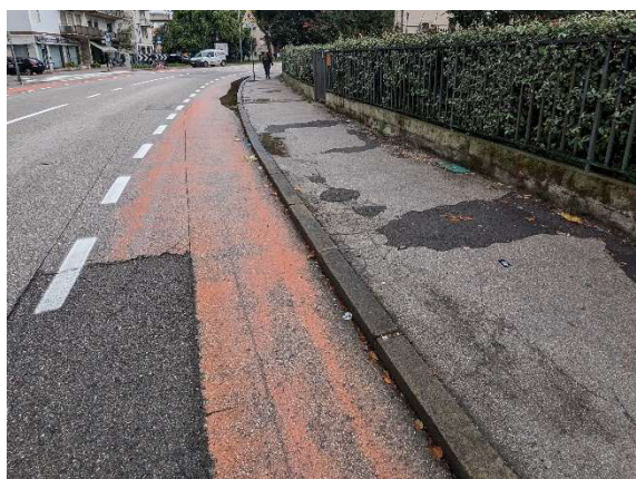
Pavimentazione marciapiede – tratto 1
