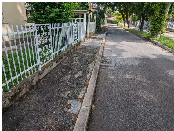
pavimentazione e cordone marciapiede ovest
