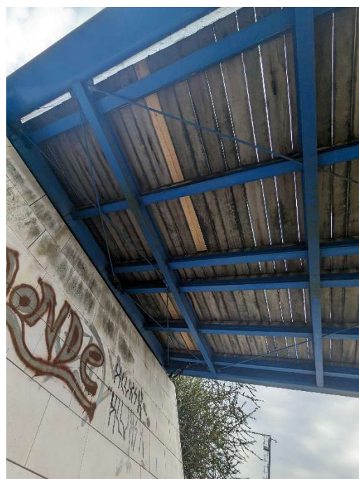
Tavole sostituite in essenza lignea diversa
