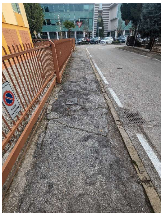
Marciapiede nord verso via Rovereto
