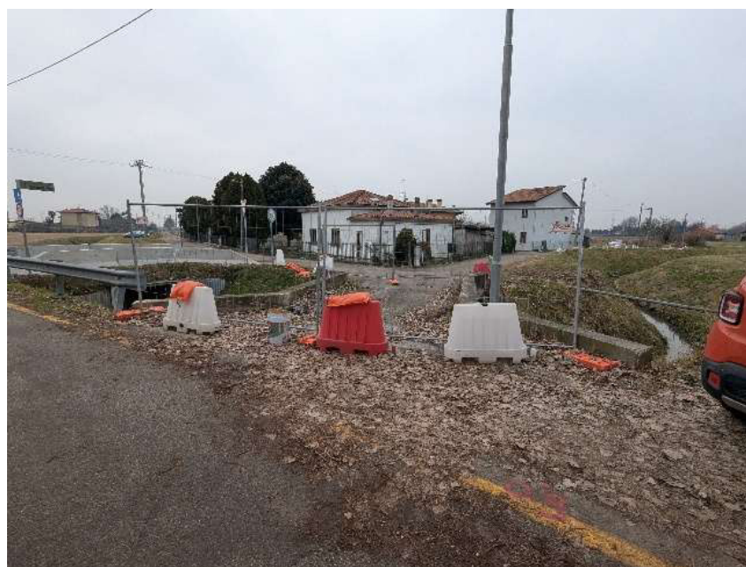
Vista del ponte esistente e del ponte provvisorio, a sud dell'esistente
