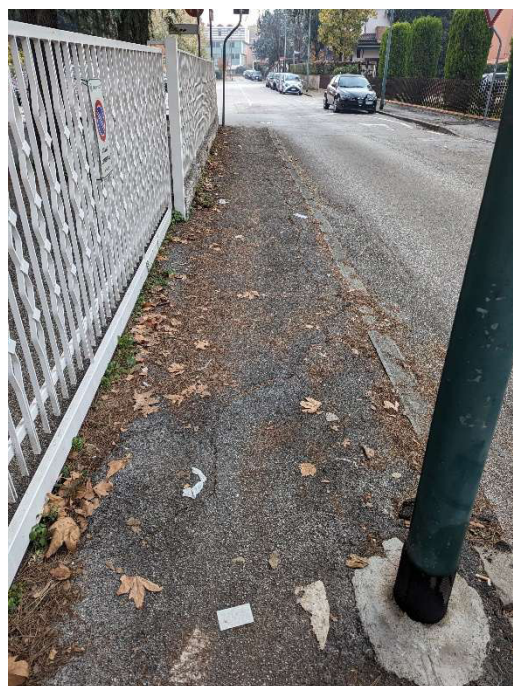
Tratto marciapiede nord verso via Enego
