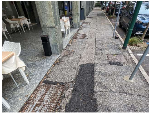
Marciapiede lato nord (con grate)
