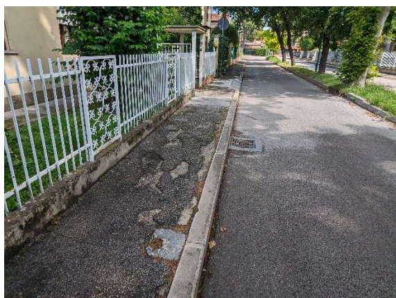
pavimentazione e cordone marciapiede ovest
