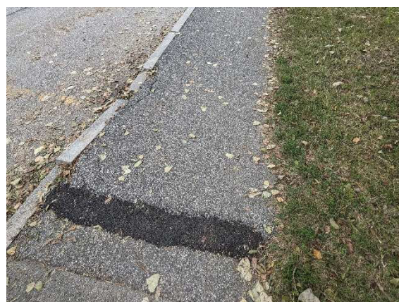
Marciapiede lato nord
