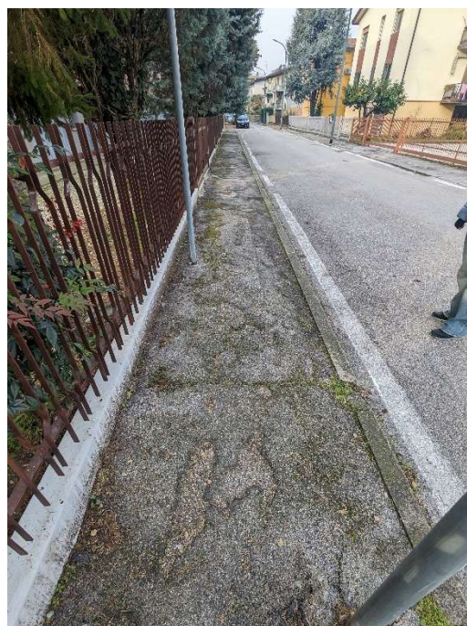
Marciapiede sud in prossimità di via Rovereto
