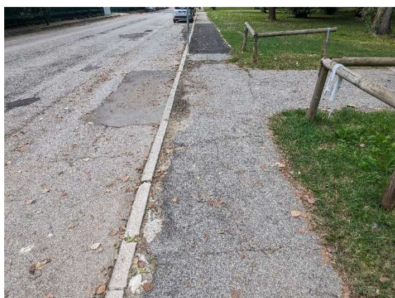
Marciapiede lato nord
