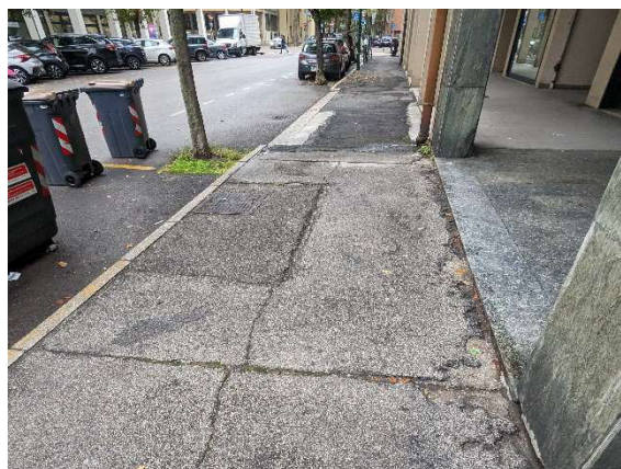
Marciapiede lato nord
