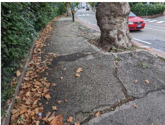
Pavimentazione marciapiede – tratto 2, aiuole alberate (platani)
