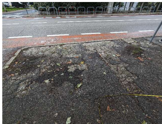
Pavimentazione marciapiede – tratto 2
