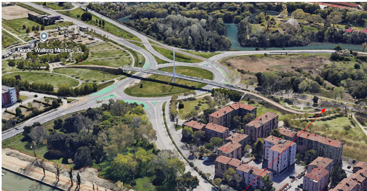
Vista aerea della passerella e dell'area di cantiere
