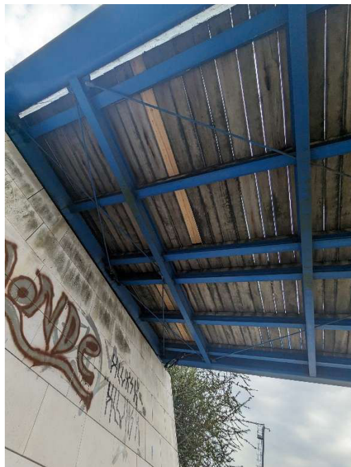
Tavole sostituite in essenza lignea diversa
