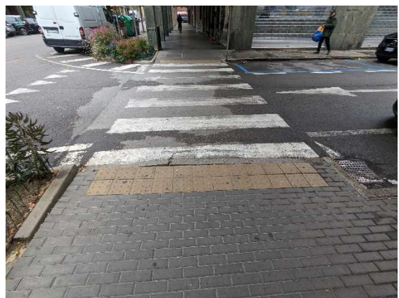
Marciapiede lato nord – attraversamento pedonale
