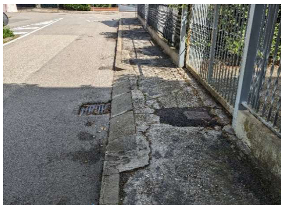
pavimentazione e cordonate marciapiede lato est
