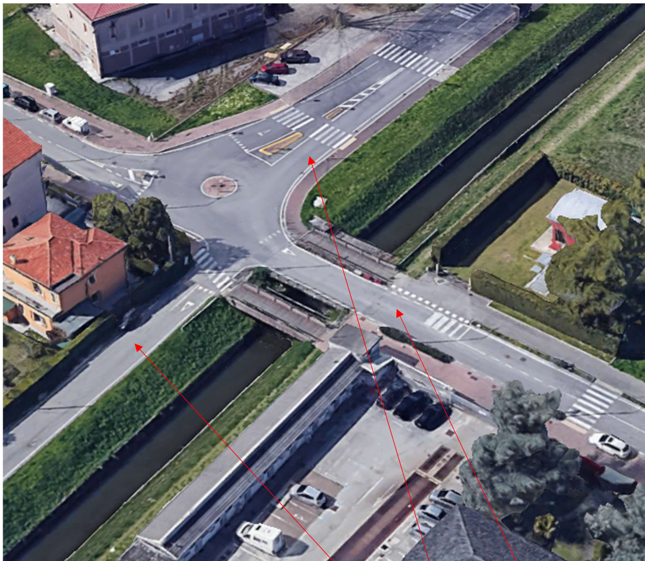
Vista aerea della passerella e dell'area di cantiere: via Scantamburlo, via Sabbadino e via Passo Campalto
