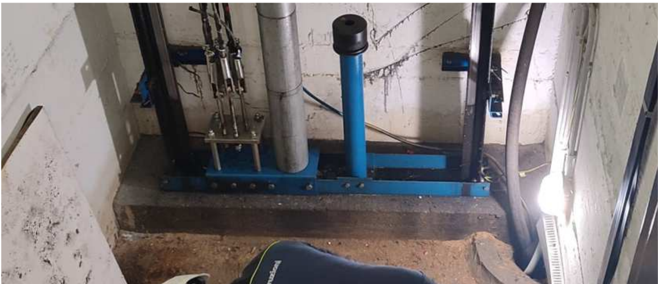
Figura 4 - Plinti in CLS esistenti da demolire
