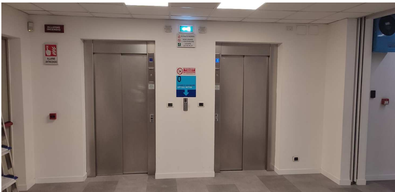
Figura 3- Vista frontale degli ascensori esistenti - piano terra
