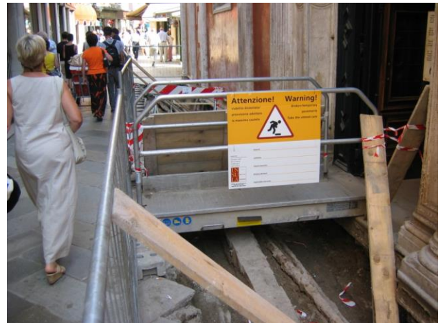
Figura 28 Esempio di viabilità pedonale per il pubblico passaggio
