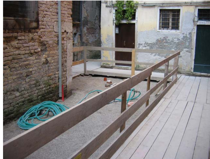
Protezione scavo per formazione passaggio temporaneo
