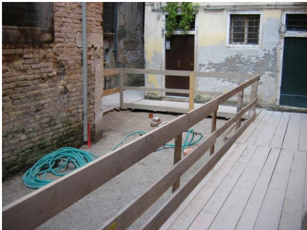
Figura 28 Esempio di viabilità pedonale per il pubblico passaggio
