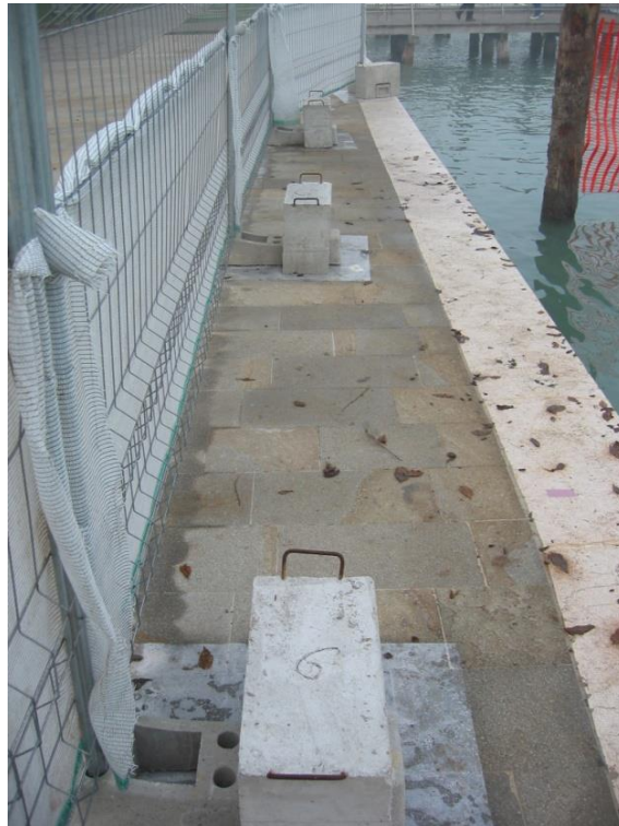
Figura 15 - Esempio di zavorra antiribaltamento
