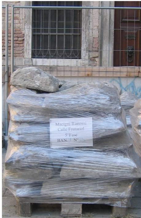
Figura 33 Esempi stoccaggio macigni
