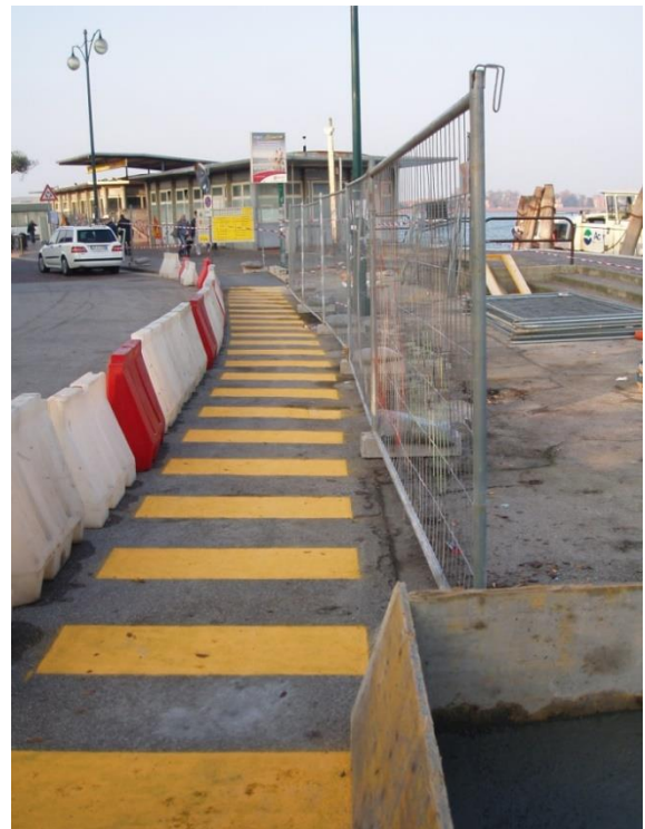
Figura 25b Assito in transenne modulari ed elementi New Jersey
