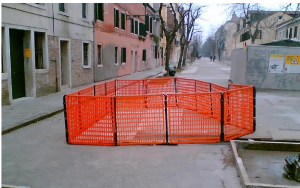
Figura 19 Assito in transenne modulari
