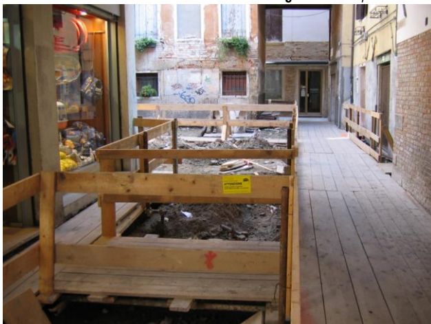
Figura 28 Esempio di viabilità pedonale per il pubblico passaggio
