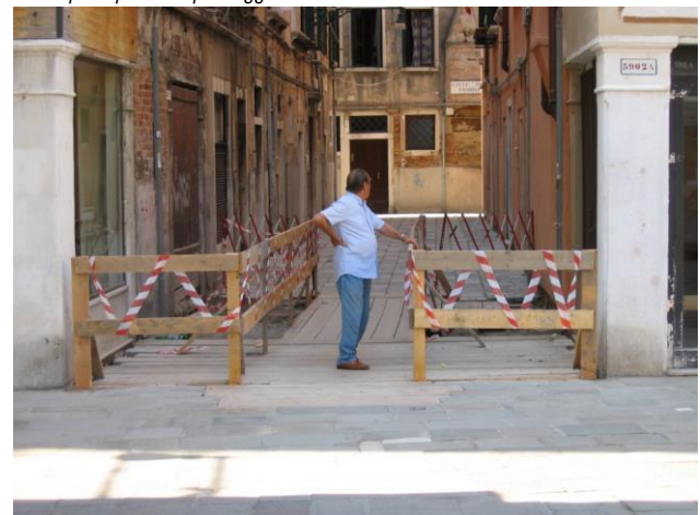
Figura 28 Esempio di viabilità pedonale per il pubblico passaggio
