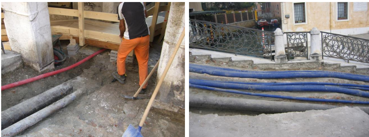
Figura 30 Esempi di cantiere ponte
