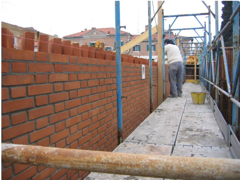
Figura 26 lavorazioni in alveo
