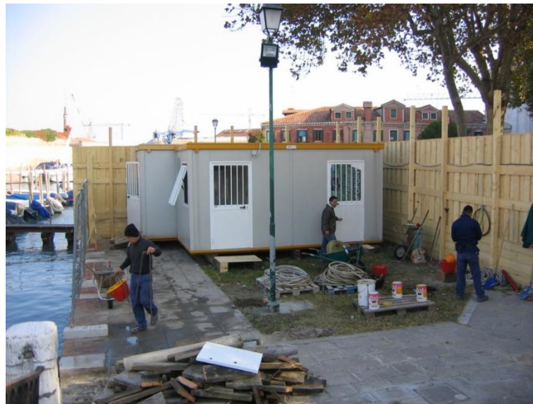
Figura 23 Installazione Box di cantiere a quota protetta
