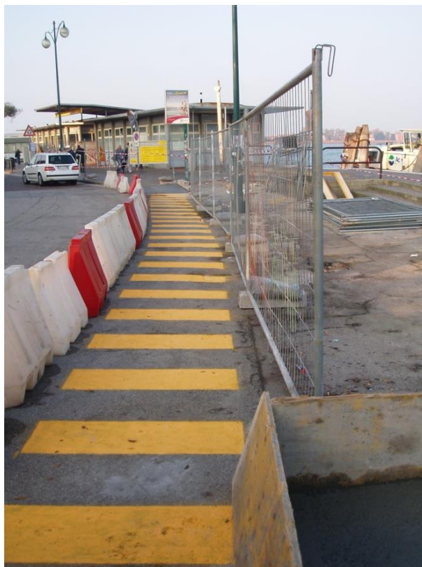
Figura 20 Assito in transenne modulari ed elementi New Jersey
