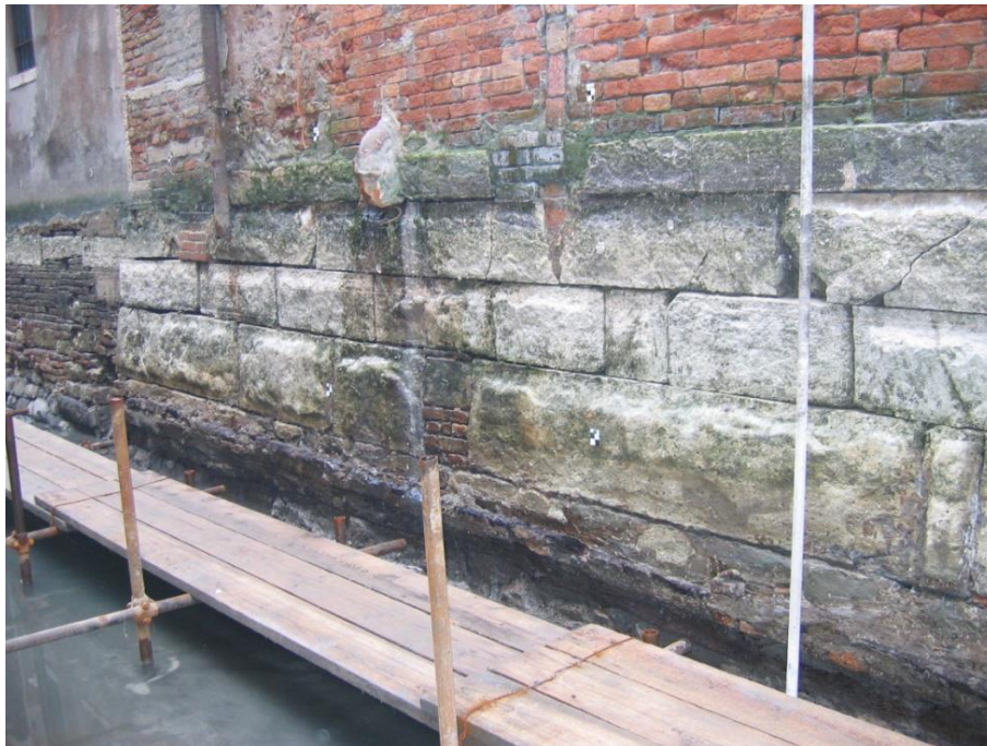
Figura 25 Camminamento in alveo
