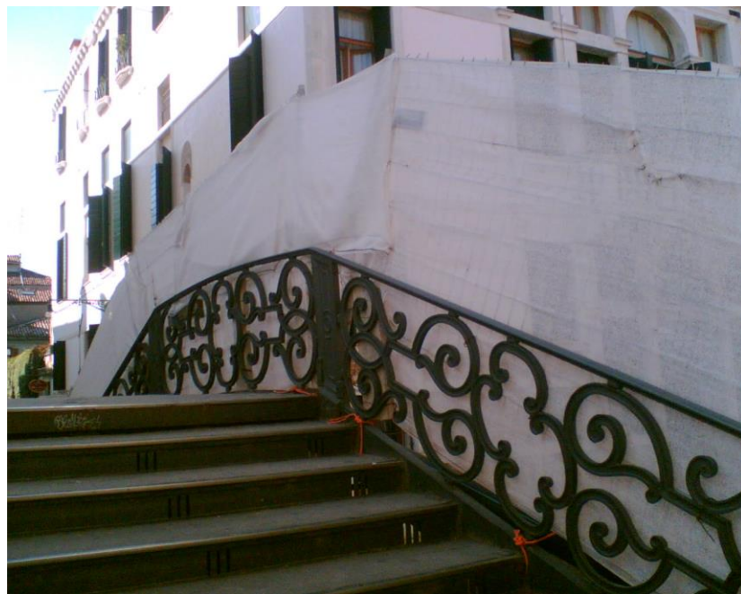
Figura 17 Assito in tavole e rete antipolvere
