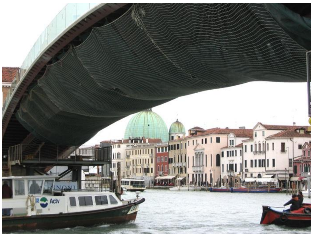
Figura 31 Protezione cantiere ponte per la viabilità pubblica
