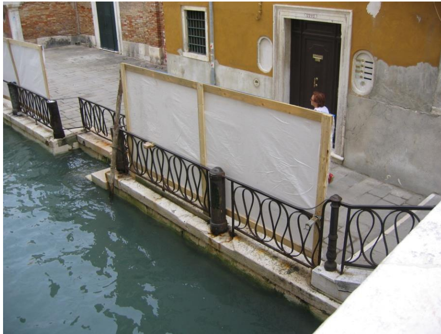
Figura 18 Assito in tavole di legno e rete antipolvere
