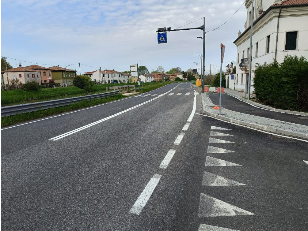
Foto n. 2 (Strada Padana Superiore direzione Oriago)
