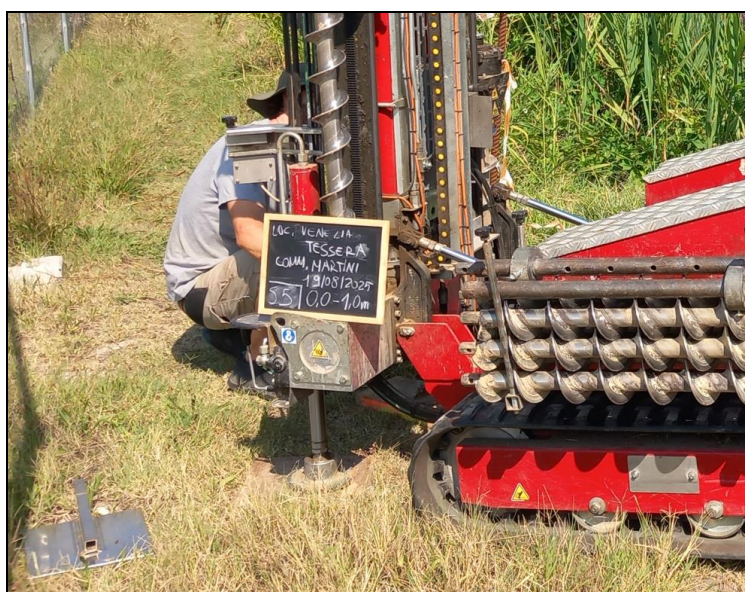
Esecuzione dei sondaggi S5
