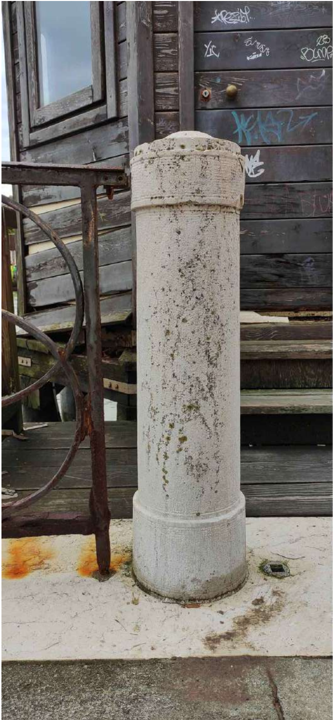
Colonna C22 Stato conservativo: - integro Intervento: - solo lavorazioni generali (vedi riepilogo in tav. 8.4.3.22)
