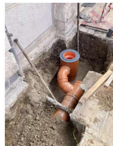
Pozzetto posato provvisoriamente
