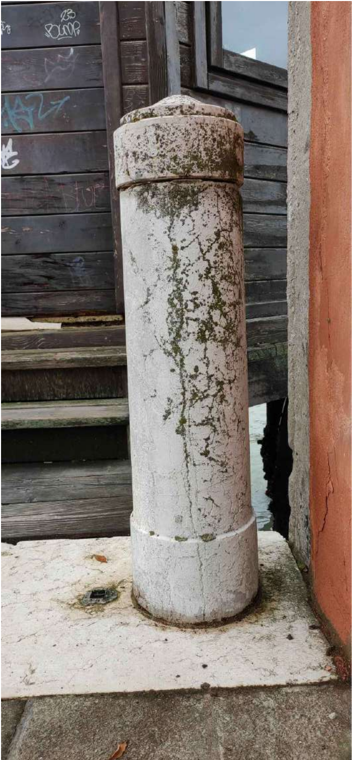
Colonna C23 Stato conservativo: - integro Intervento: - solo lavorazioni generali (vedi riepilogo in tav. 8.4.3.22)
