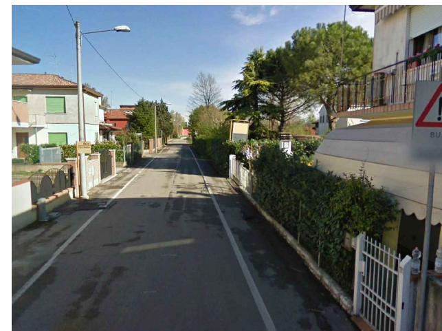
2. VIA TERRAGLIETTO: realizzazione area stradale rialzata - stato di fatto
