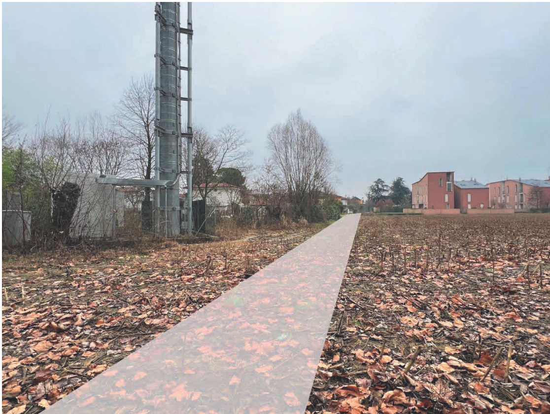
Vista della sede del percorso Verso Via Istria
