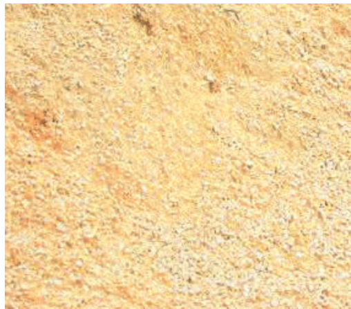
Materiale Impiegato per la realizzazione del tracciato, misto cementato costipato (sarone)
