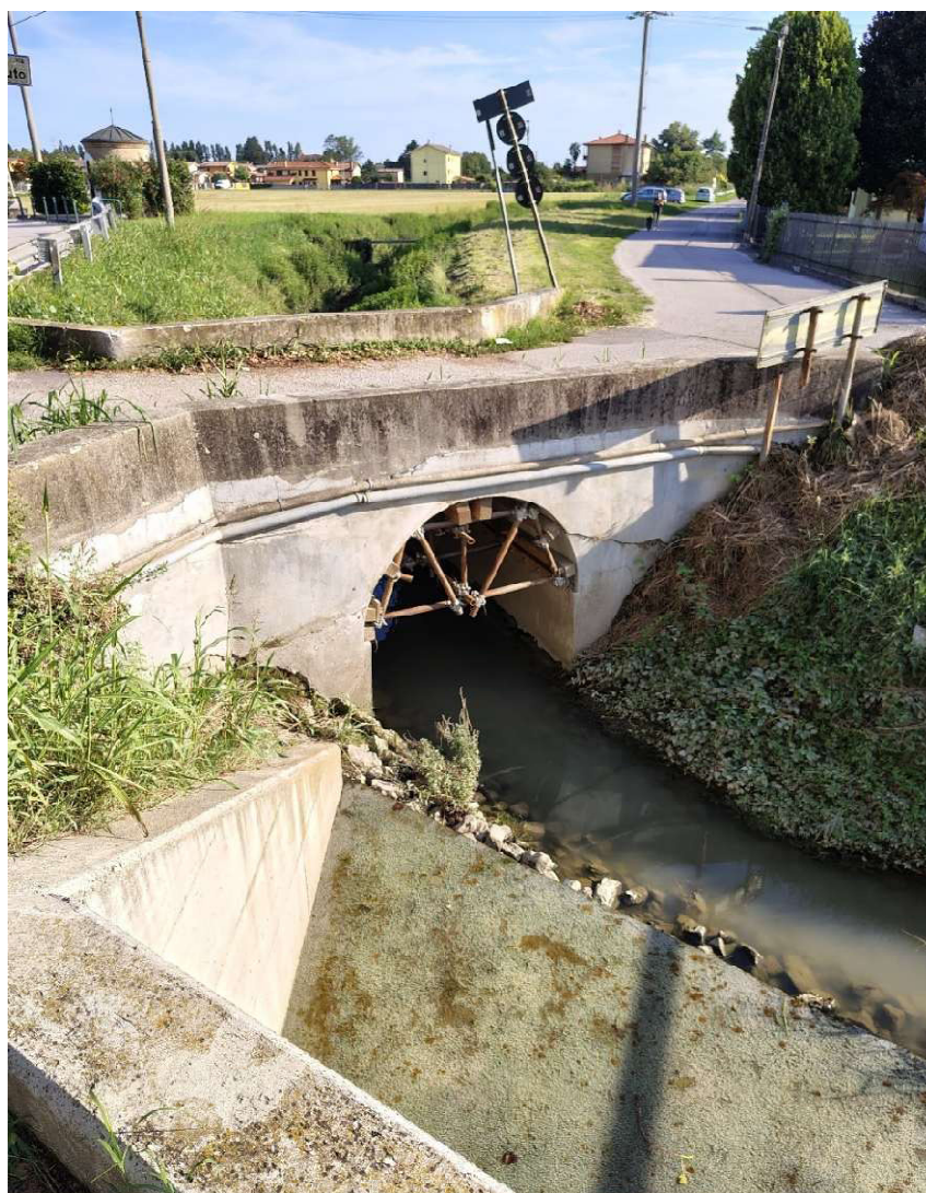
Ponte esistente rinforzato con centina
