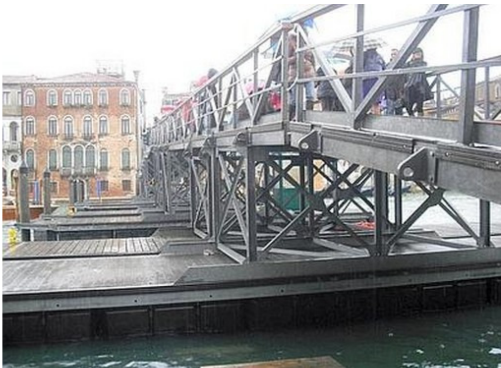
Particolare del ponte della Salute.
