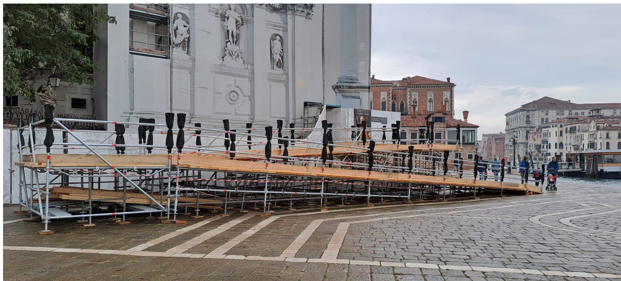
Rampa provvisoria per eliminare le barriere architettoniche per accedere alla Basilica della Salute.
