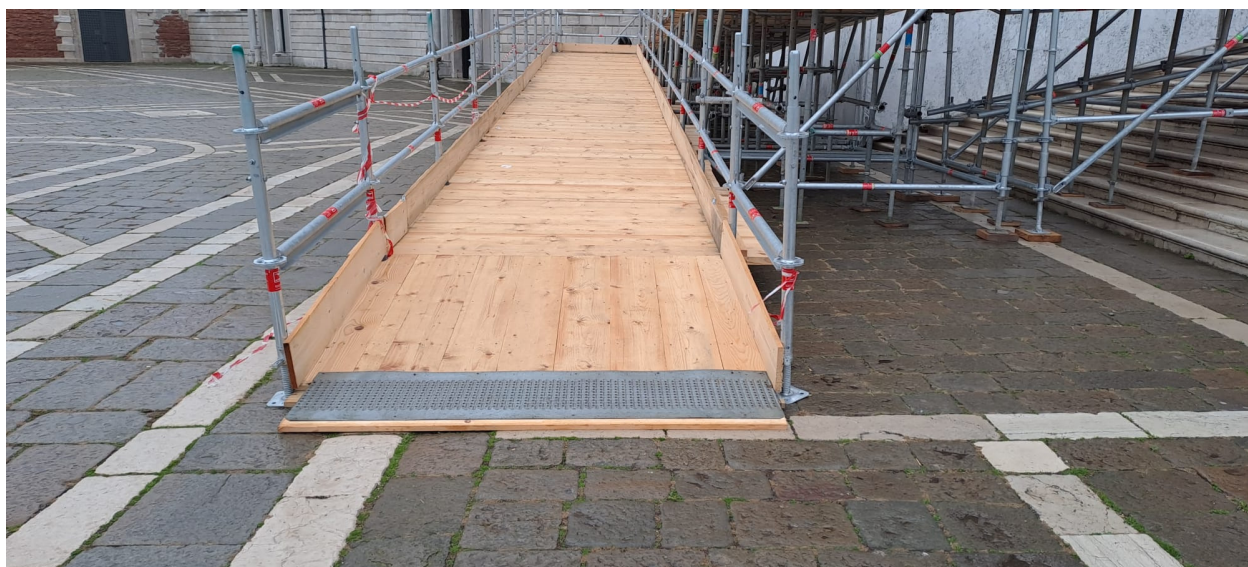
Accesso alla rampa dalla fondamenta.
