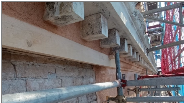
Fig. 21. Rifacimento cornici modanate
