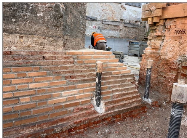
Fig. 14. Ciminiera – Danneggiamenti fondali ripristinati in urgenza
