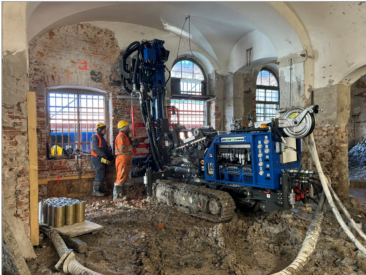
Fig. 5. Edificio 7 – trivellazione micropali fra gli allineamenti 1-4
