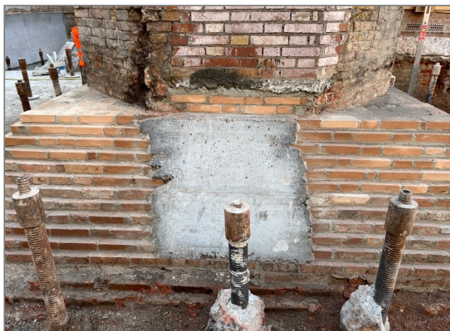
Fig. 15. Ciminiera – Avvenuto consolidamento apparato fondale
