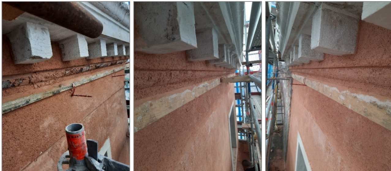
Fig. 20. Rifacimento cornici modanate
