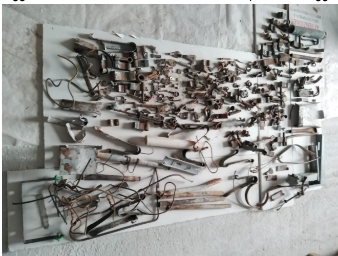
Fig. 26. Elementi metallici rimossi dalle facciate
