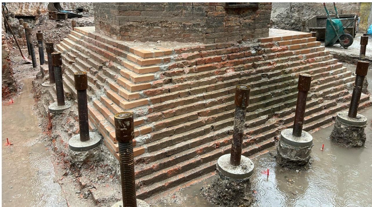
Fig. 16. Ciminiera – Avvenuto consolidamento apparato fondale
