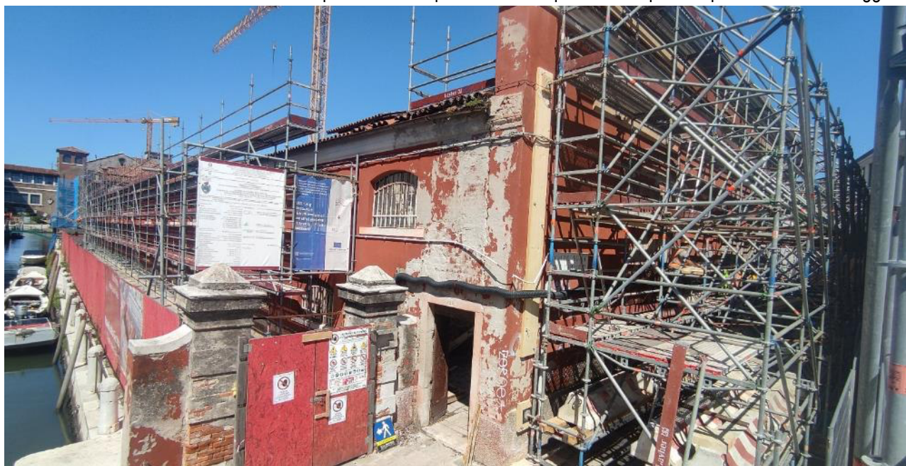
Fig. 17. Edificio 13 – Opere di messa in sicurezza muro su Calla nuova dei tabacchi, già messe a punto con la PdV.02
