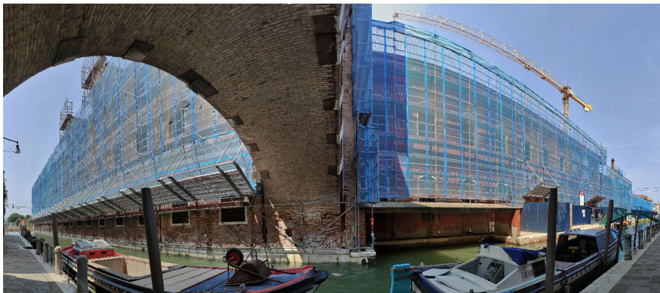
Fig. 32. Vista area di cantiere e ponteggi lato Rio delle Burchielle
