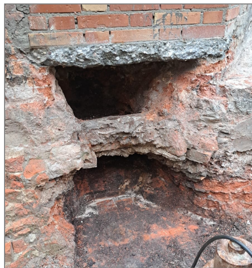
Fig. 14. Ciminiera – Danneggiamenti fondali ripristinati in urgenza
