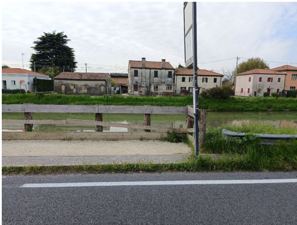
Foto n. 5 (fermata bus esistente oggetto di richiesta)
