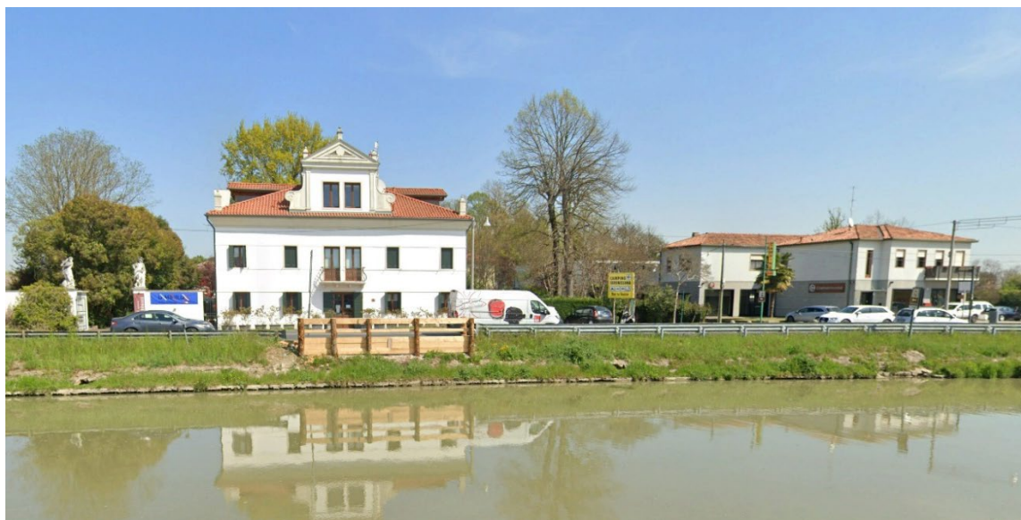
Foto n. 9 (vista stato attuale fermata esistente)
