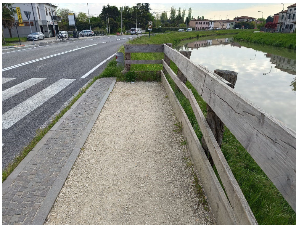
Foto n. 3 (fermata bus esistente oggetto di richiesta)
