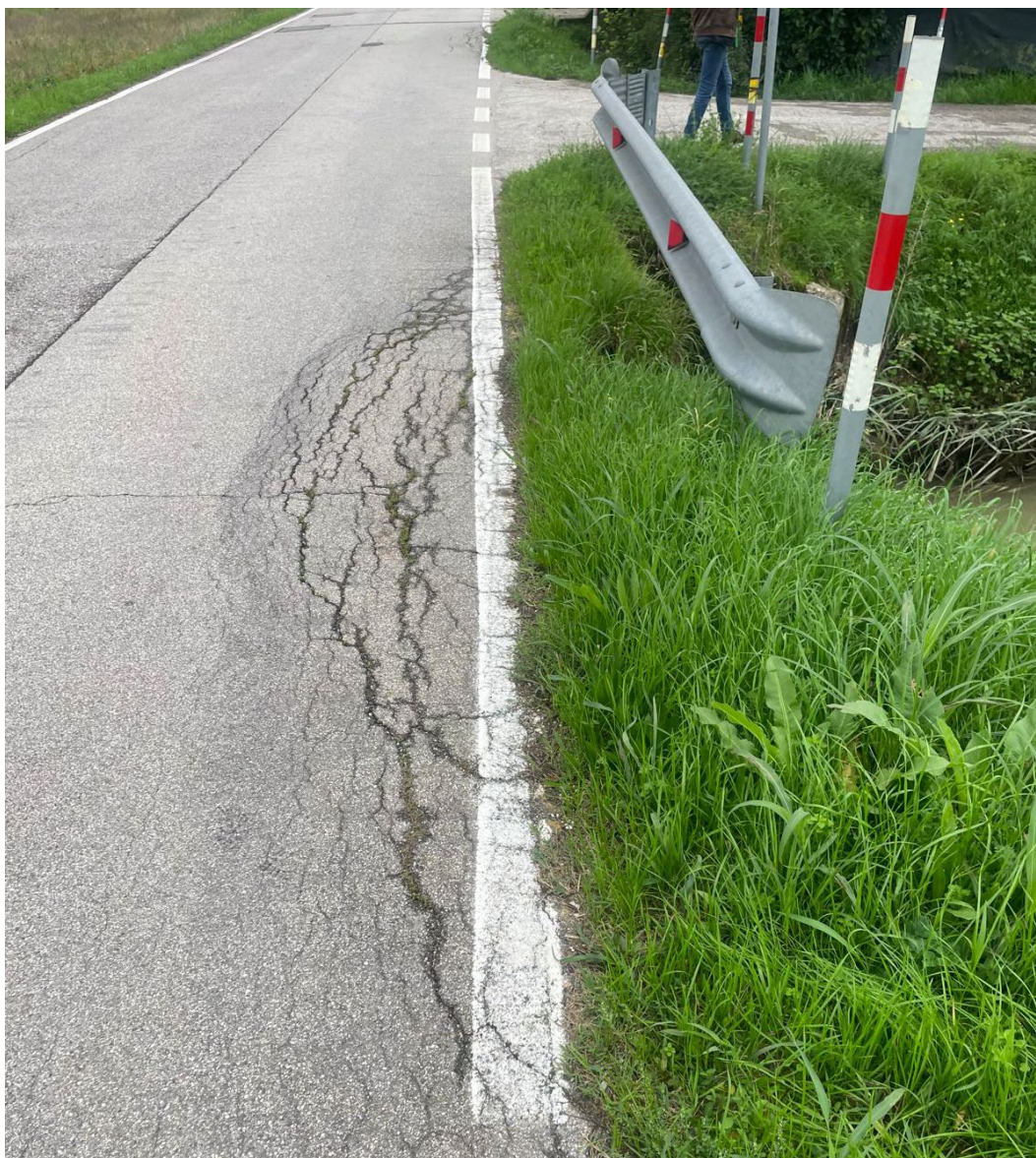
Figura 1.39 – dissesto/cedimento sede stradale e argine
