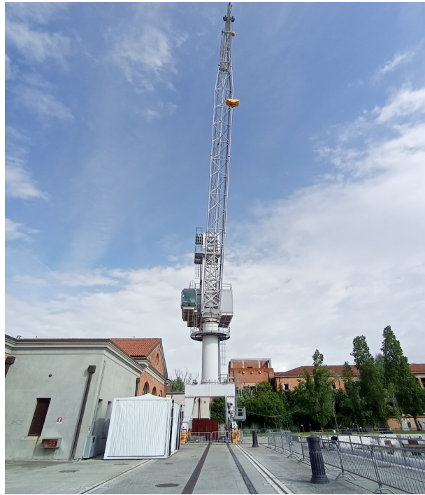
Fig. 4.3: Fotografia di una delle due gru Cimolai in prossimità del Bacino di Carenaggio Medio
