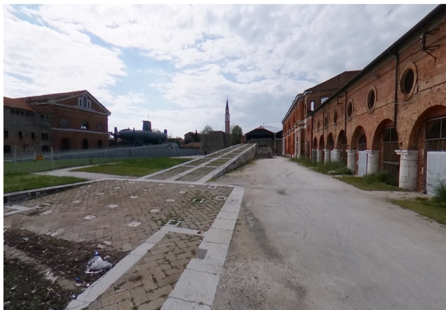
Fig. 4.2: Fotografia dello scalo di alaggio nord
