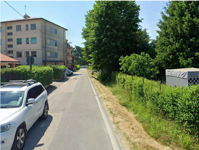
2. VIA TERRAGLIETTO civ. 146a: realizzazione area stradale rialzata - stato di fatto
