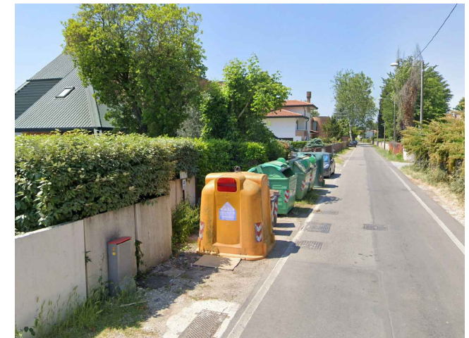
2. VIA CA' SAGREDO: nuova pavimentazione isola ecologica - stato di fatto
