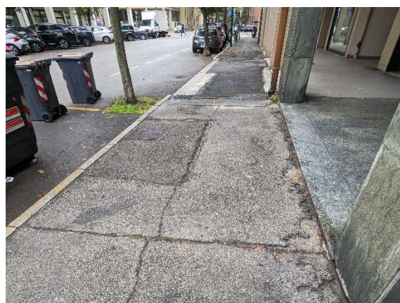
Marciapiede lato nord
