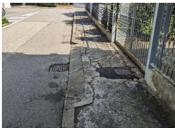
pavimentazione e cordonate marciapiede lato est
