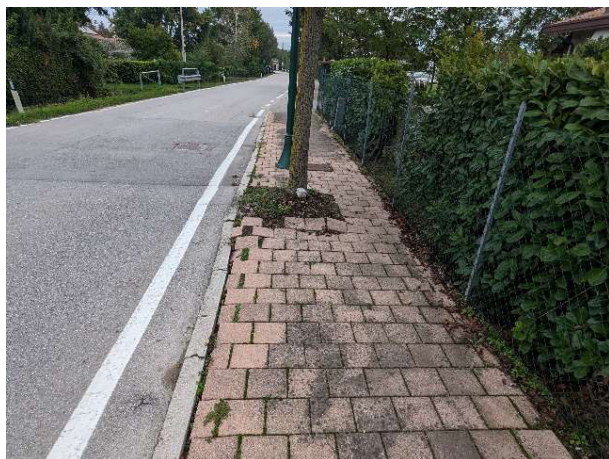
via Litomarino - pavimentazione in betonelle sconnessa
