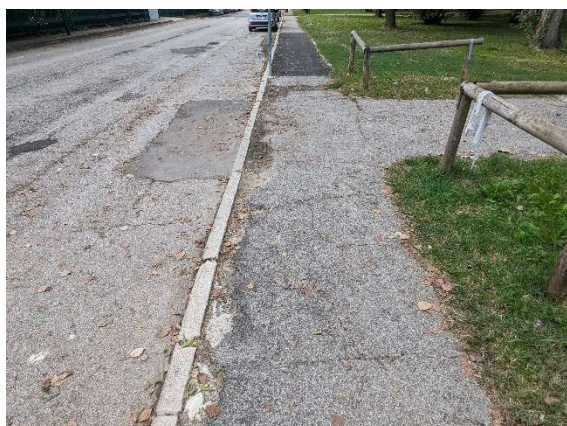
Marciapiede lato nord
