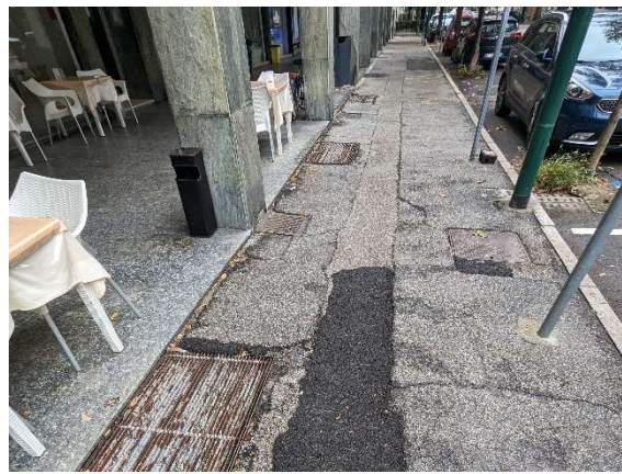
Marciapiede lato nord (con grate)
