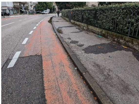
Pavimentazione marciapiede – tratto 1
