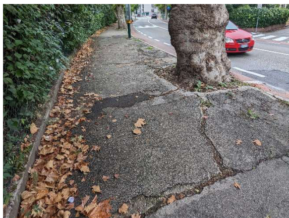
Pavimentazione marciapiede – tratto 2, aiuole alberate (platani)
