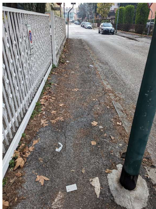
Tratto marciapiede nord verso via Enego
