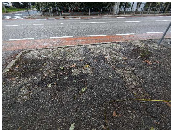
Pavimentazione marciapiede – tratto 2
