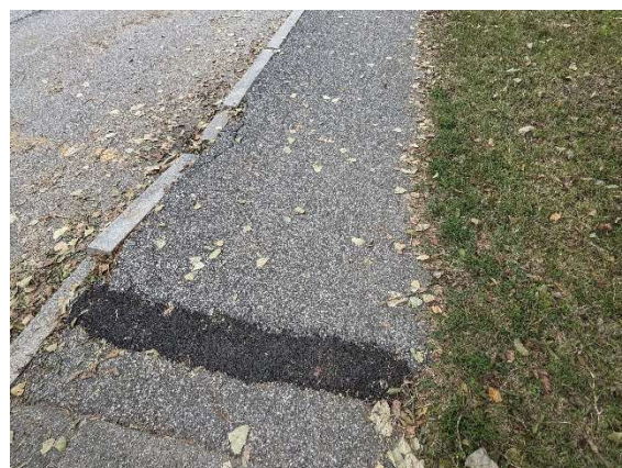
Marciapiede lato nord
