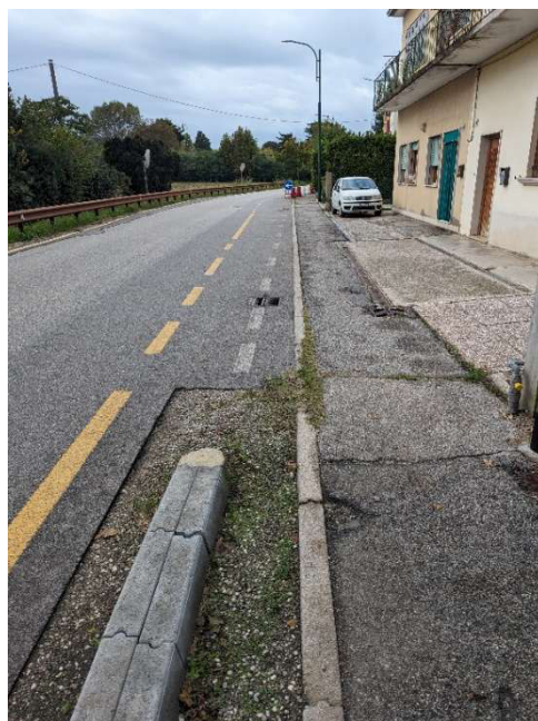
Linea gialla e cordone da rimuovere
