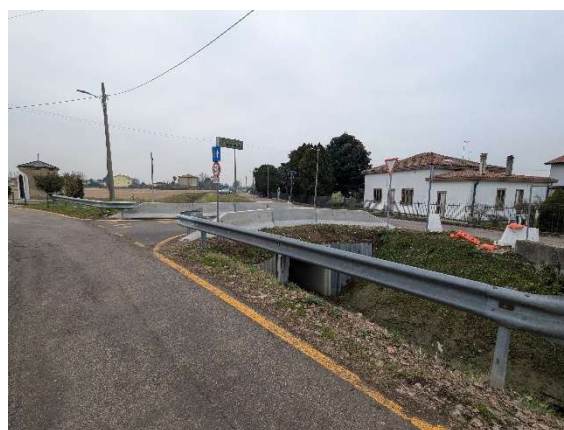
Ponte provvisorio a sud del ponte esistente
