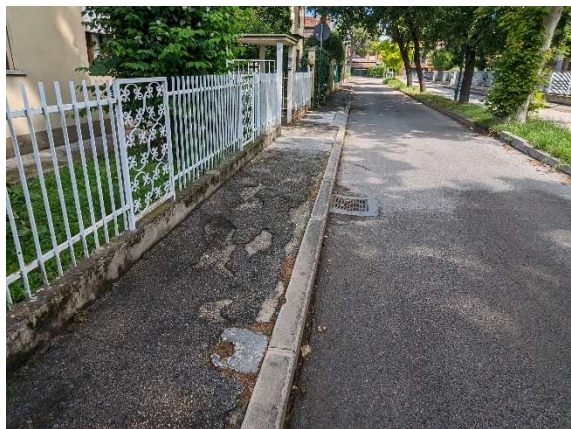
pavimentazione e cordone marciapiede ovest
