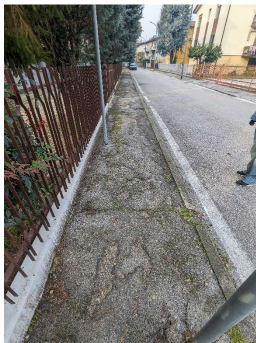
Marciapiede sud in prossimità di via Rovereto
