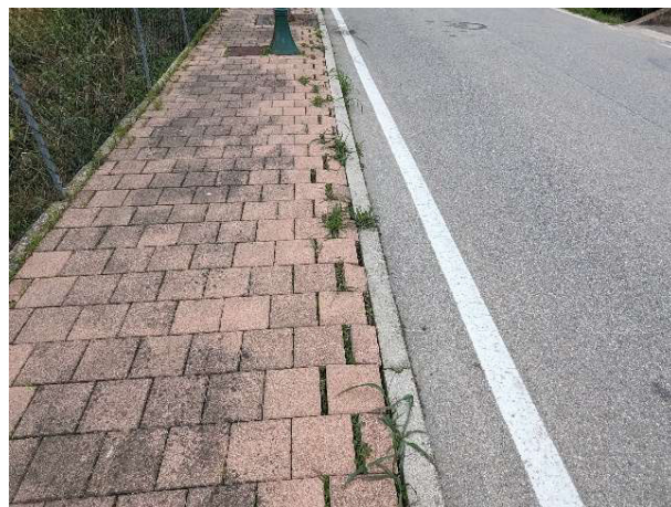
via Litomarino - pavimentazione in betonelle sconnessa
