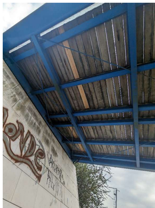
Tavole sostituite in essenza lignea diversa
