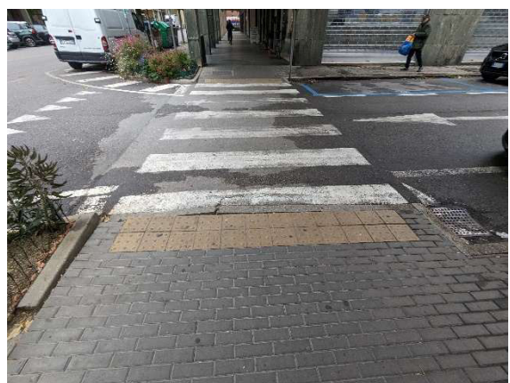
Marciapiede lato nord – attraversamento pedonale
