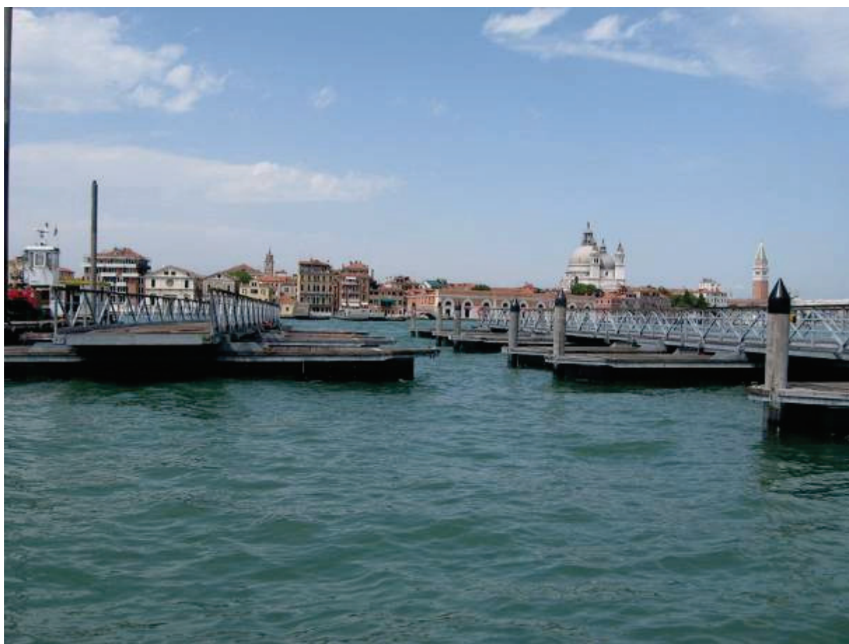
Particolare dell'ormeggio provvisorio degli elementi modulari
