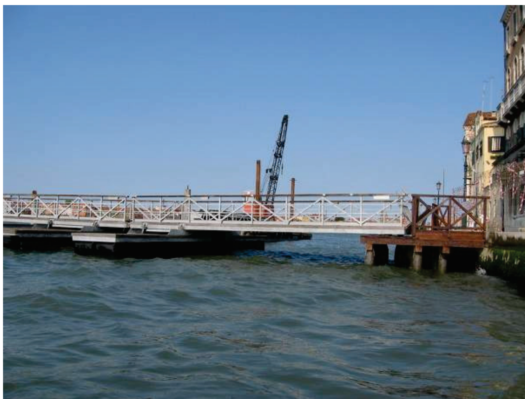
Testata del ponte
