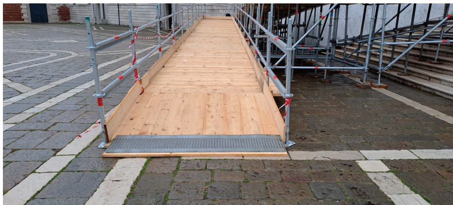
Accesso alla rampa dalla fondamenta.
