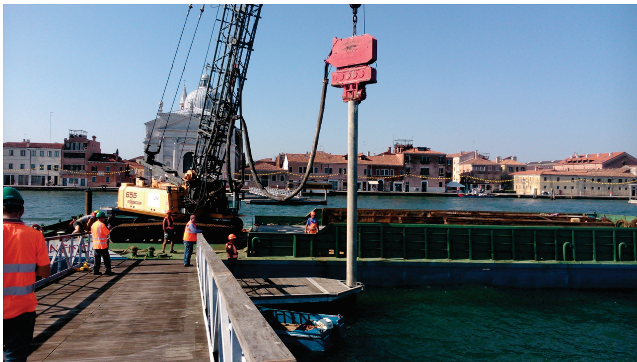
Infissione pali di ormeggio
