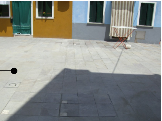
trachite a giunto unito - nuova pavimentazione
