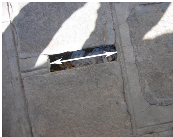
Mancanza totale della fuga con presenza di foro
