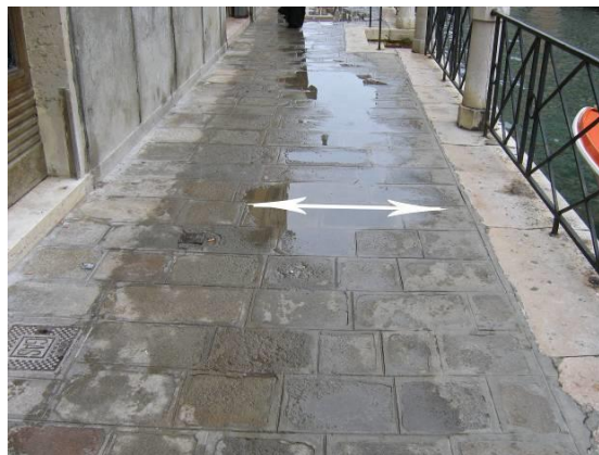
Avvallamento ridotto ( L < 1,2 m) dal grado di ostruzione basso (0 - 25%)
