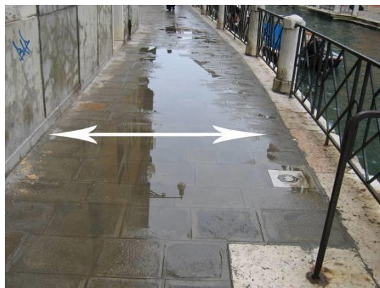
Esempi di ostruzione al 100%; entrambi gli avvallamenti hanno larghezza maggiore di 1,2 m.
