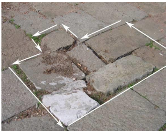
Dissesto con presenza di discontinuità (scalini), un caso estremo
