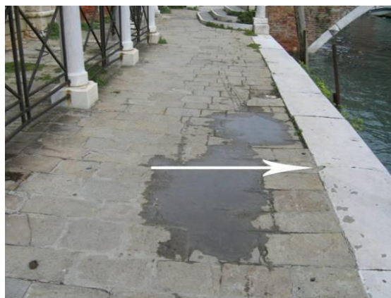
Esempio di come in caso di depressione multiforme si debba considerare, in fase di rilevamento, la larghezza massima ostruita.
