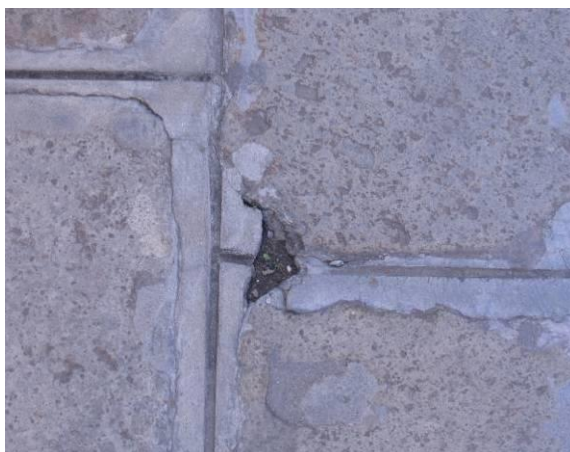
Pavimentazione a giunto fugato
