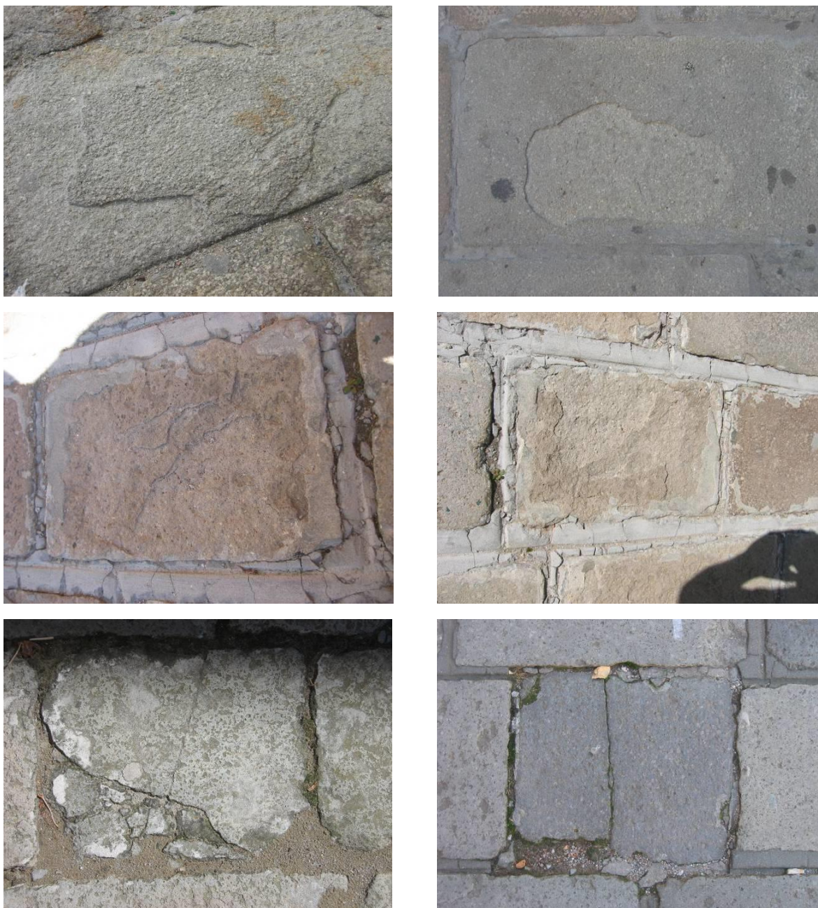
Esempi di diversi tipi di usura della pavimentazione
