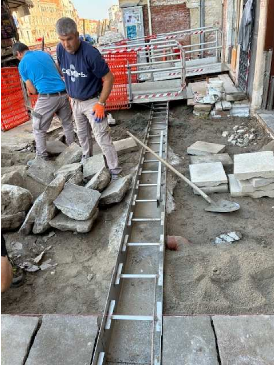
Figura 24 posa telaio della canaletta in acciaio inox
