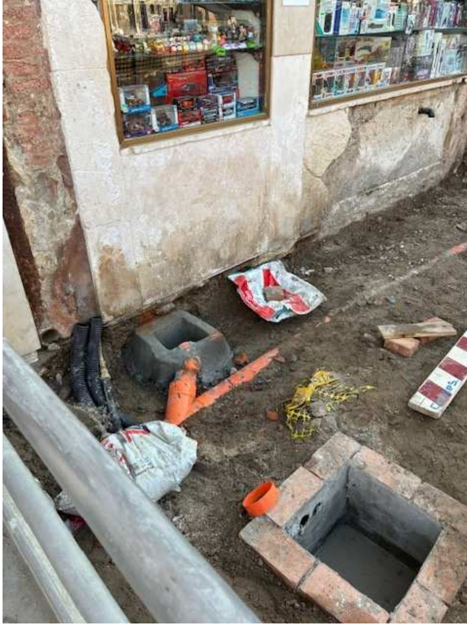
Foto 23 posa collettore DN200 con pozzetto caditoia e pozzetto corrugato
