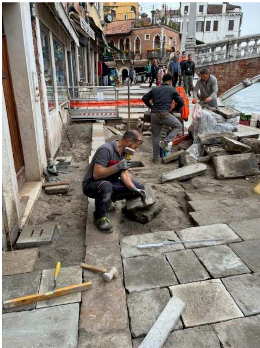
Foto 21 posa masegni nell'area della pescheria con predisposizione per la canaletta
