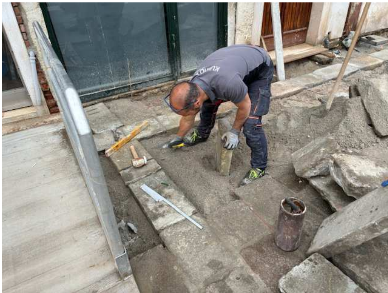
Foto 22 predisposizione sottofondo per posa masegni nell'area della pescheria con predisposizione per la canaletta
