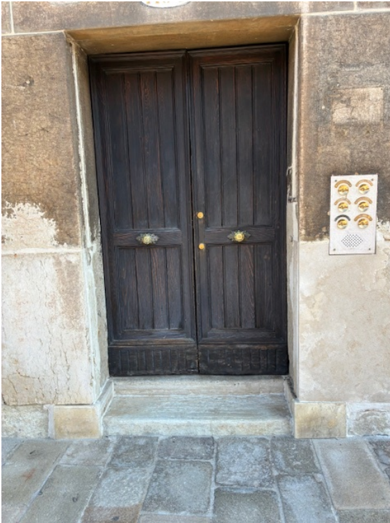
Fig. 13 - Il civ 1104 ha potuto ridurre l'alzata dei gradini da 18 cm a 12 cm
