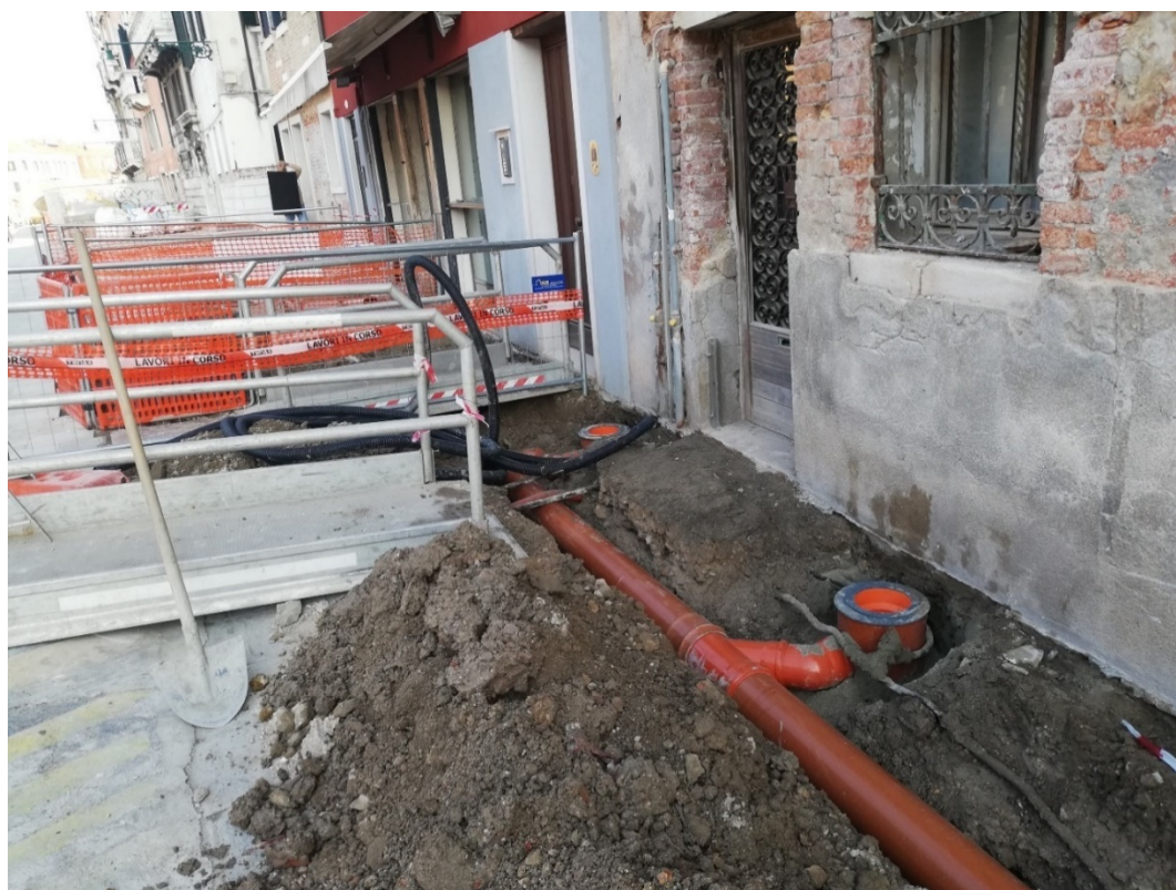
Fig. 8 - posa delle condotte per le acque meteoriche
