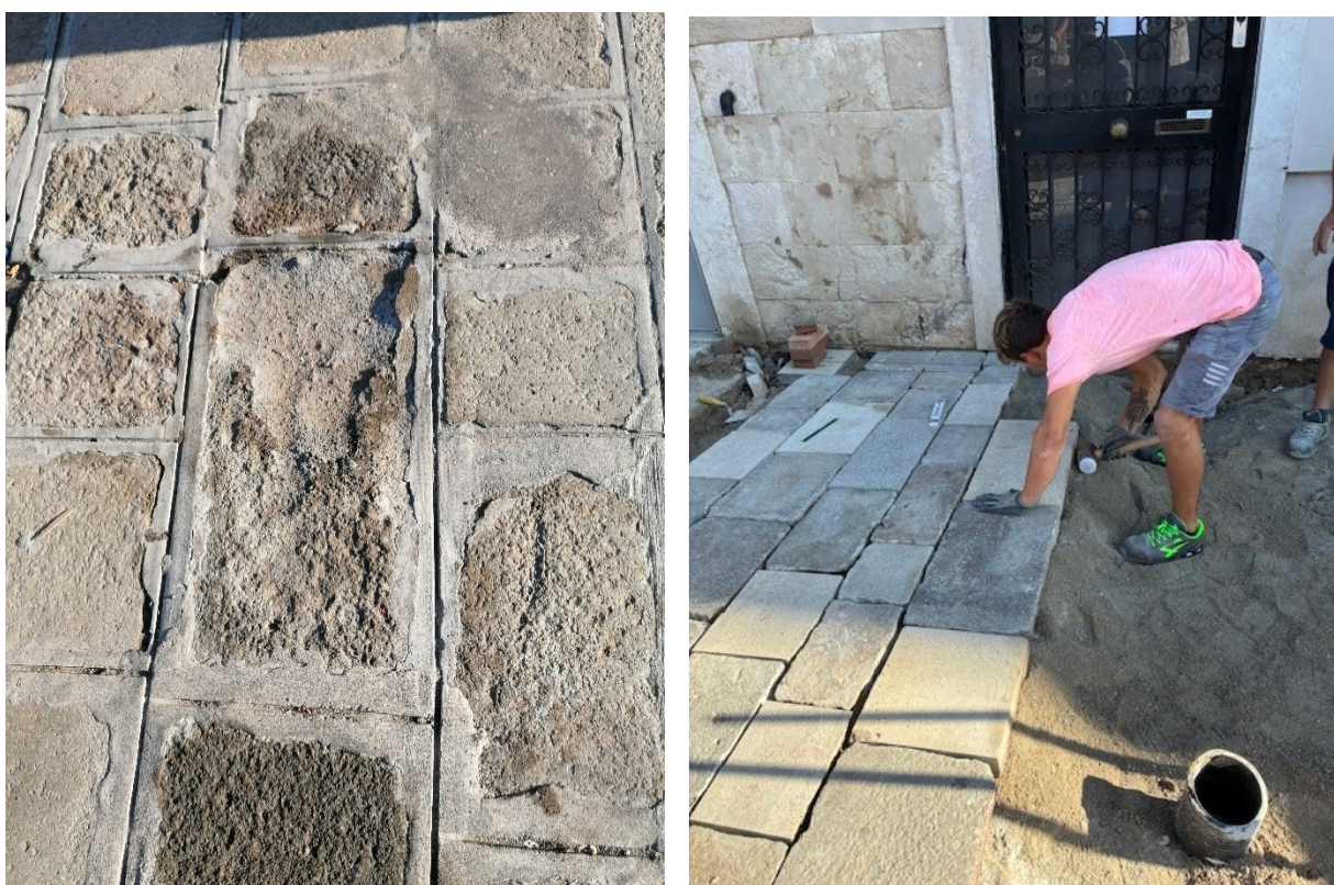
Fig. 10 – intervento di posa dei masegni prima (a sx) e dopo (a dx)
