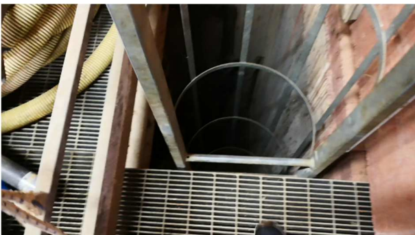
Accesso piano interrato depuratore
