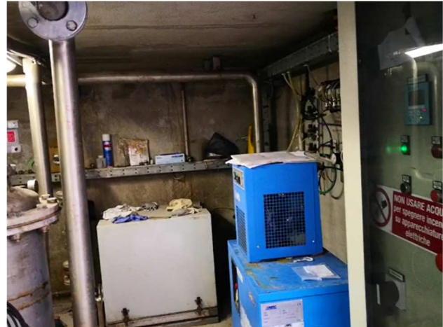
Interno Locale tecnico
