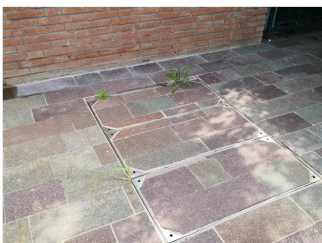
Accesso al piano interrato dall'esterno
