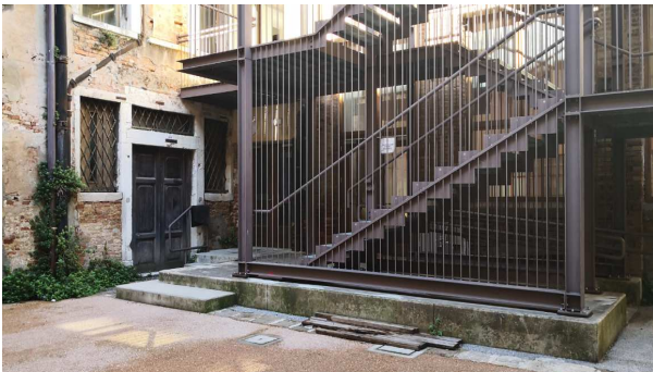
Cortile interno scuola – scala antincendio
