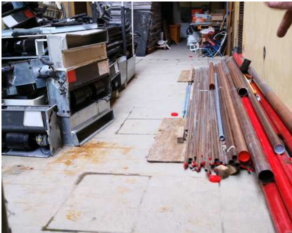
Vasche di sedimentazione
