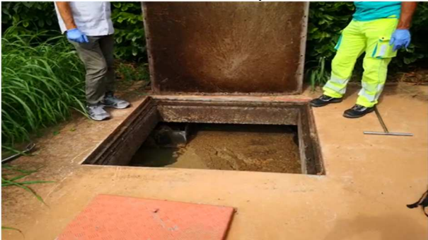
Chiusini vasche presedimentazione, sollevamento, ossidazione
