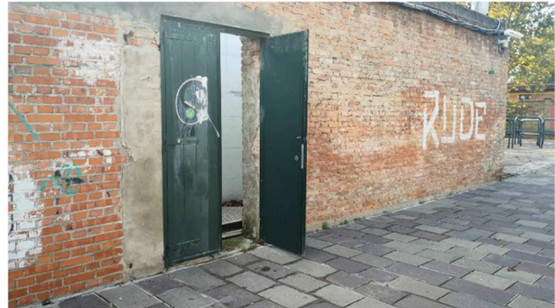
Ingresso da calle S.Elena
