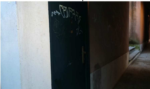
Locale quadro elettrico
