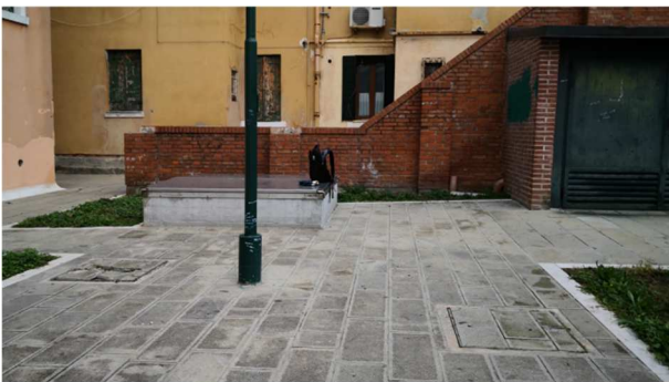
Area vasche impianto
