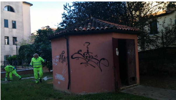
Foto 1 Locale tecnico impianto depurazione
