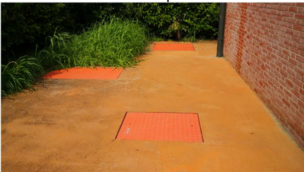
Chiusini vasche presedimentazione, sollevamento, ossidazione
