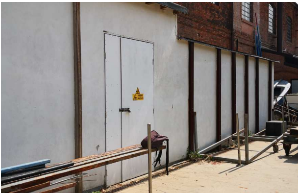
Ingresso Locale Tecnico (Centrale vuoto e filtri)
