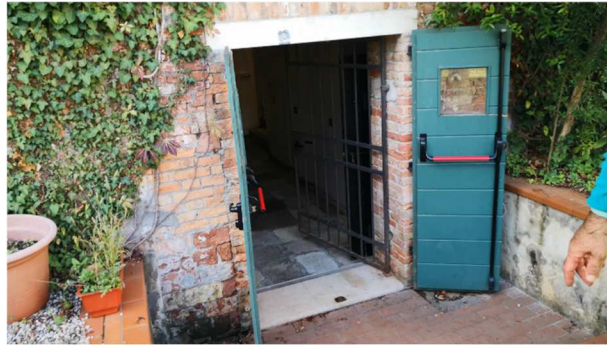
Ingresso locale tecnico da giardino
