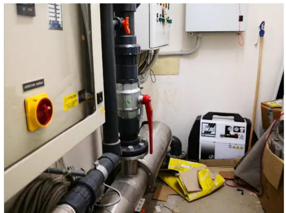
Interno locale tecnico quadro e soffiante
