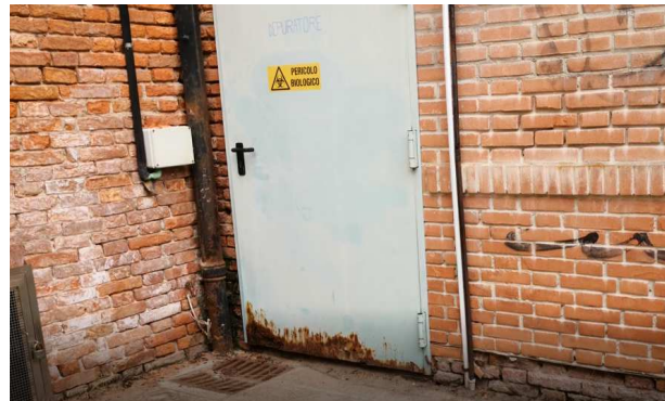
Accesso Locale tecnico
