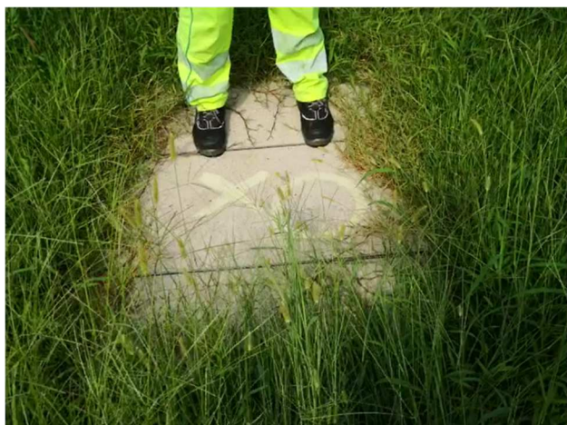
Pozzetto vasca di ossidazione
