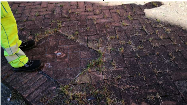
Pozzetti vasca ossidazione
