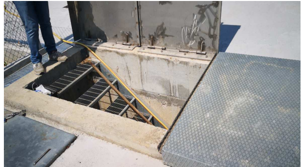
Accesso al locale tecnico
