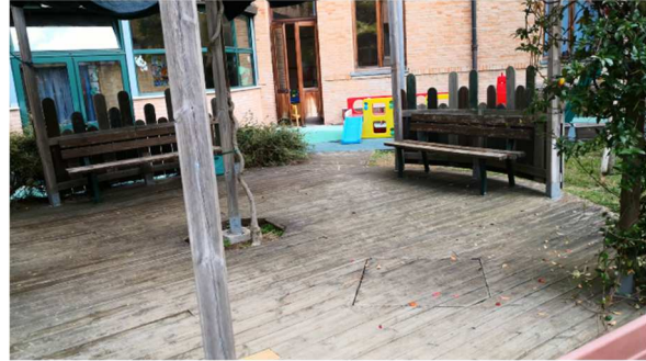
Corte interna - passo d'uomo
