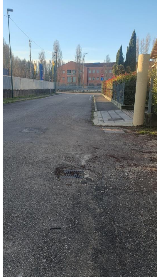
Caditoie di raccolta acque meteoriche, pendenza verso via Castellana
