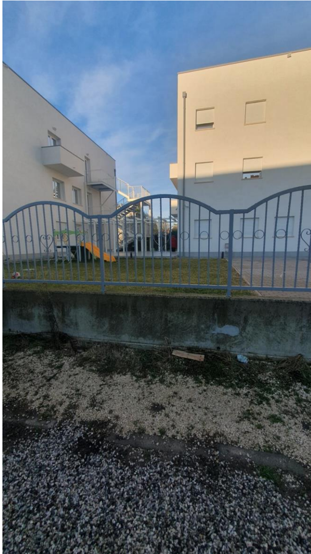
Muretto di recinzione esistente su Via Ricci
