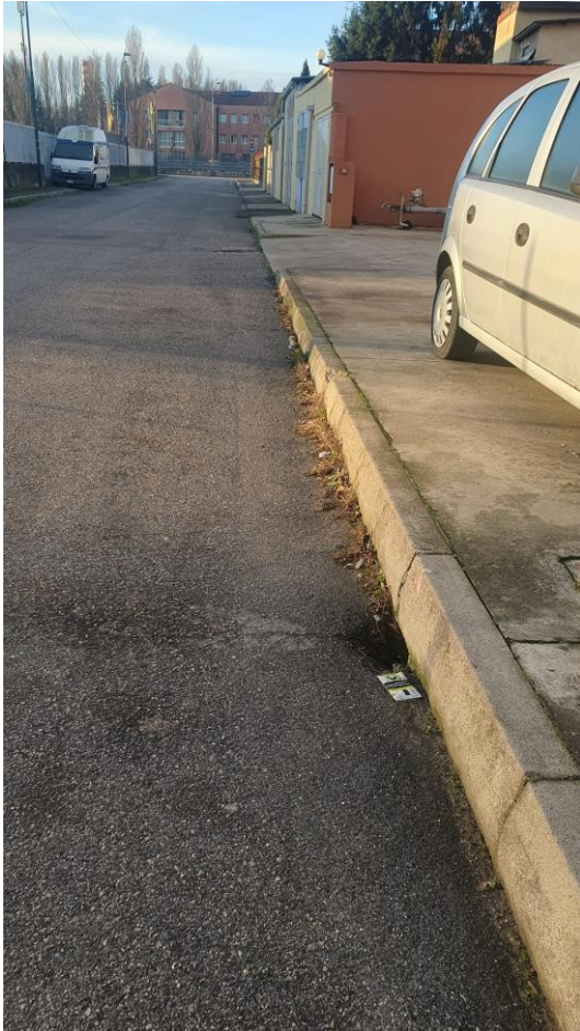
Caditoie di raccolta acque meteoriche, pendenza verso via Castellana
