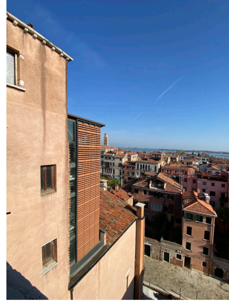
VISTA ESTERNA DAL SOTTOTETTO
