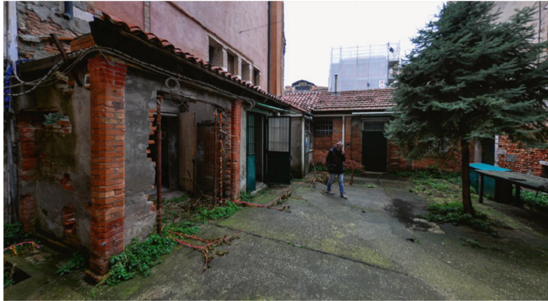
VISTA DELLE BARACCHE DA DEMOLIRE
