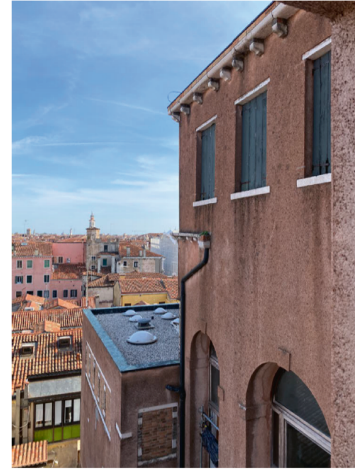
VISTA ESTERNA DAL VANO SCALA S1
