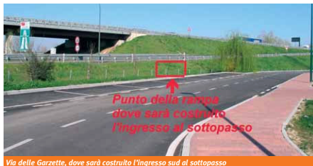
Via delle Garzette, dove sarà costruito l'ingresso sud al sottopasso
