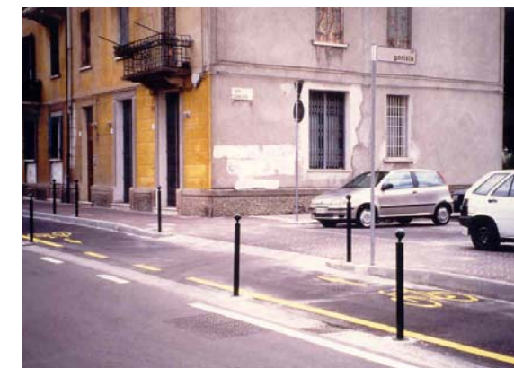
Sbocco di strada laterale a quota marciapiede
