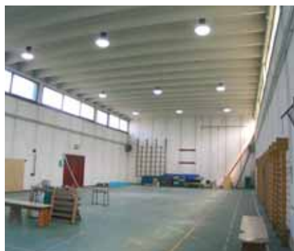
>> I lavori in corso alla palestra dell'ex scuola De Nicola, sul soffitto sono visibili i
