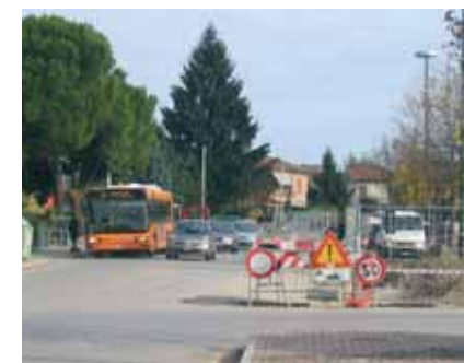
>> Cantieri del tram.
