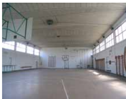
>> I lavori in corso alla palestra della scuola Renato Fucini, in attesa della posa del parquet è già stato ultimato il controsoffitto
