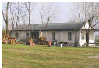
Il fabbricato della sala polivalente (edificio C), prima e dopo il restauro
