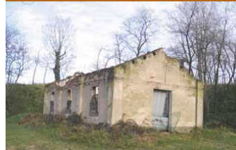
La "casa della musica" (edificio D) prima e dopo il restauro
