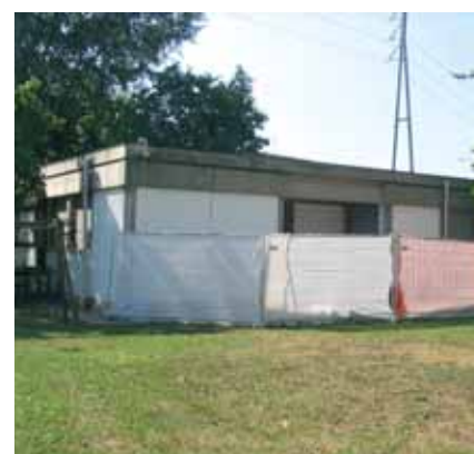
>> I lavori di ampliamento della scuola materna Cucciolo
