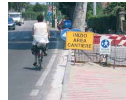
>> I nuovi marciapiedi in costruzione in via Altinia, tra via Ca' Solaro e il parcheggio
