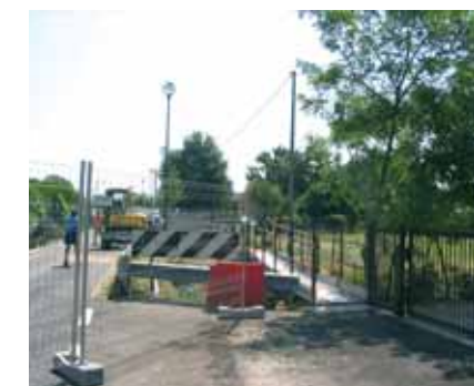
>> La passerella provvisoria installata in
