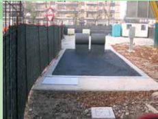
La piattaforma al livello stradale, che ricopre il cassone per la raccolta dei rifiuti.
