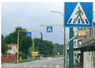
I nuovi pannelli a portale per segnalare i passaggi pedonali
